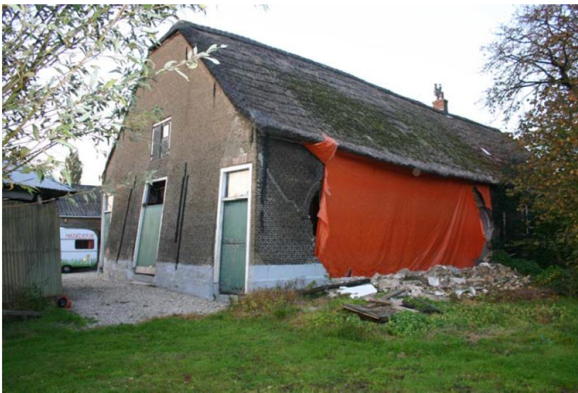
Figuur 7: foto bestaande situatie
