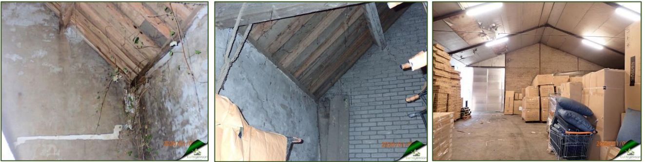
Figuur 6. Binnenruimte schuurgedeelte Bredeweg 110
