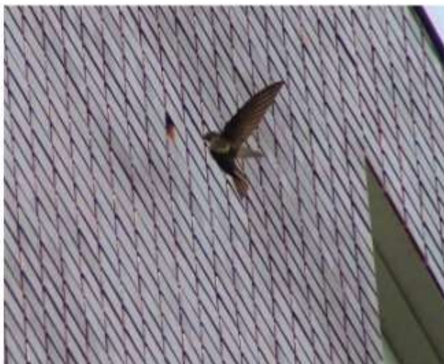
Gierzwaluwsteen weggewerkt in gevel
