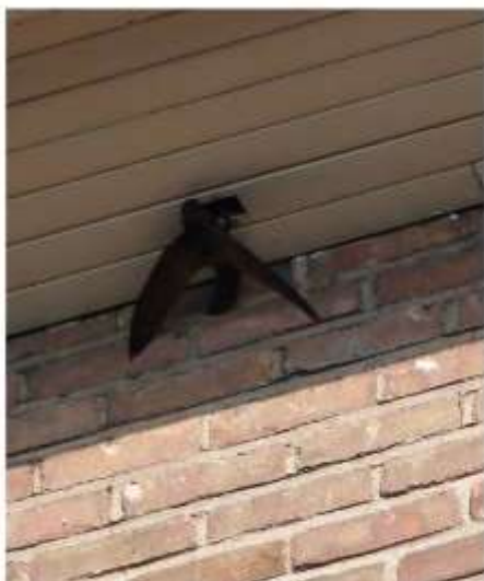
Gierzwaluwsteen weggewerkt in dakrand
