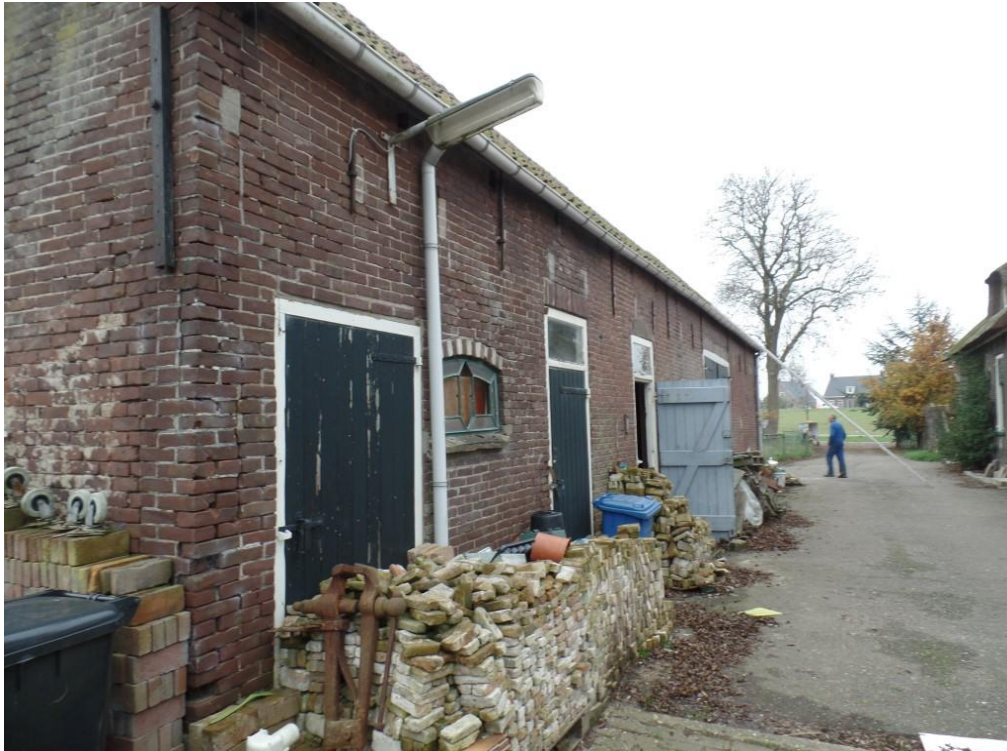
Figuur 9: De muur aan de noordwestzijde van de af te breken schuur.
