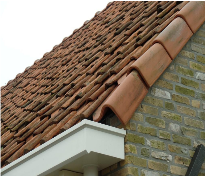
Figuur 8: het Oudhollandse pannendak van de gerenoveerde boerderij.
