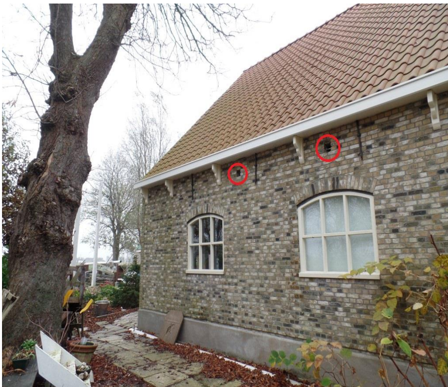
Figuur 4: achterzijde van de woonboerderij, de ventilatieopeningen in de spouw omcirkeld.
