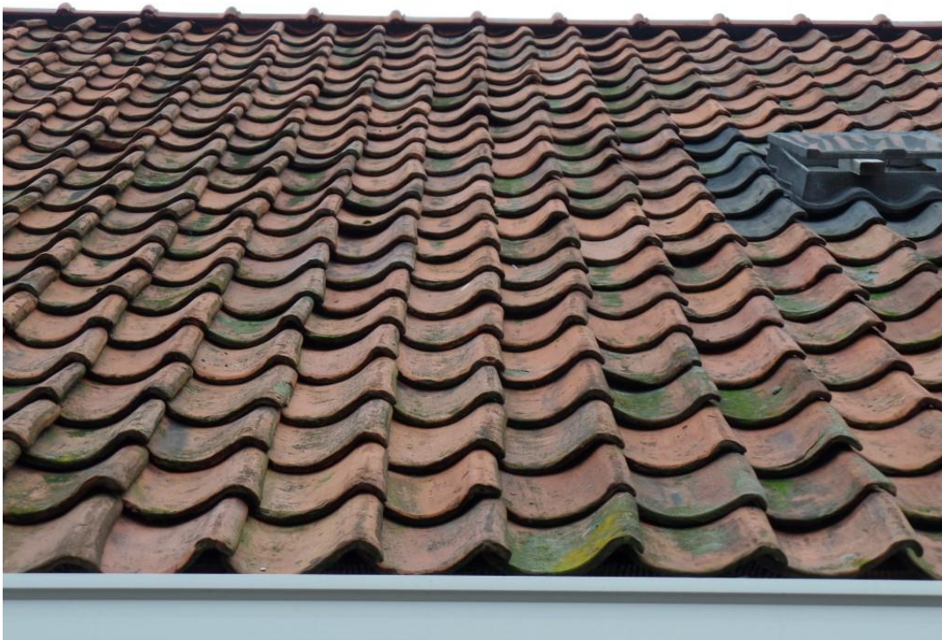
Figuur 3: Oudhollands pannendak van het gerenoveerde (achterste) deel van de woonboerderij.
