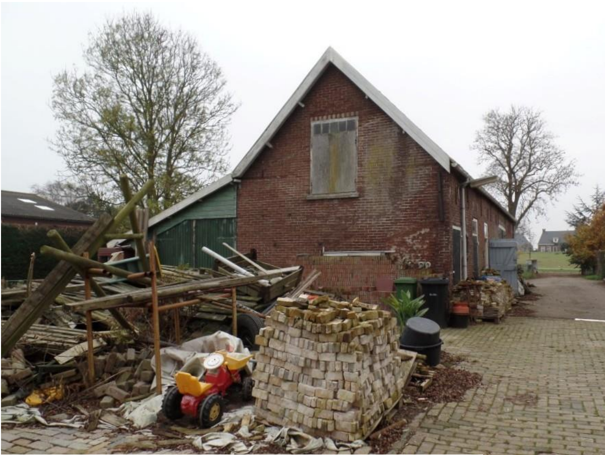
Figuur 2: de af te breken stenen schuur.
