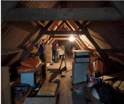
Figuur 6: zolder van de af te breken schuur met dakbeschot.
