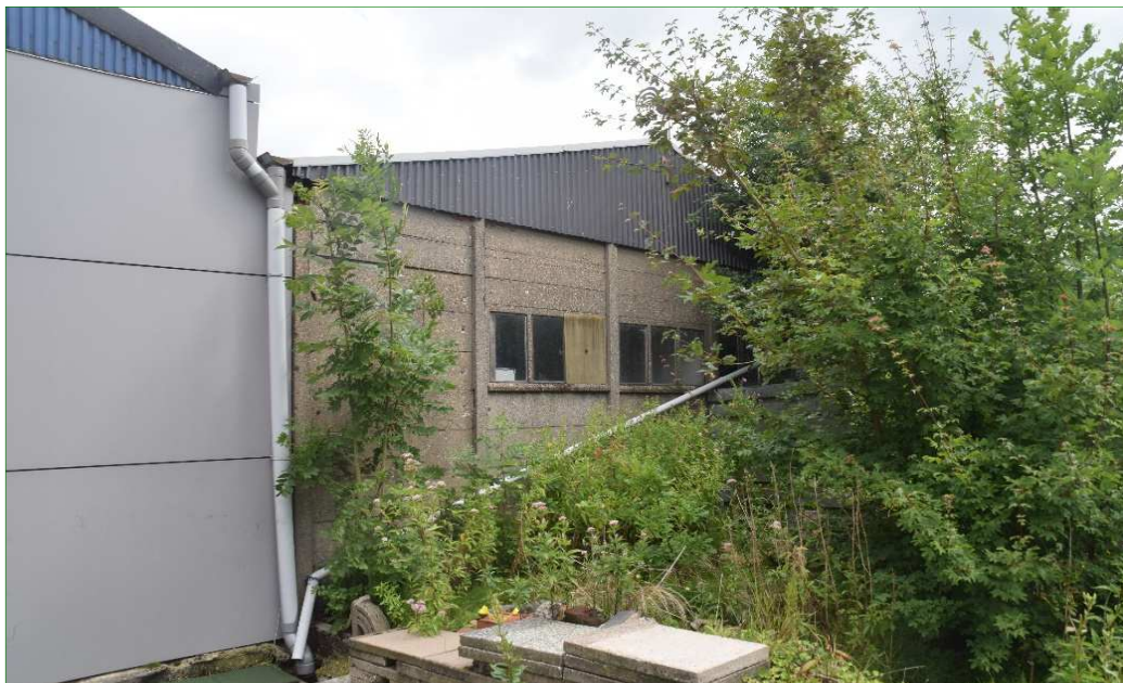
Links de te behouden schuur/lood en rechts de af te breken schuur.
