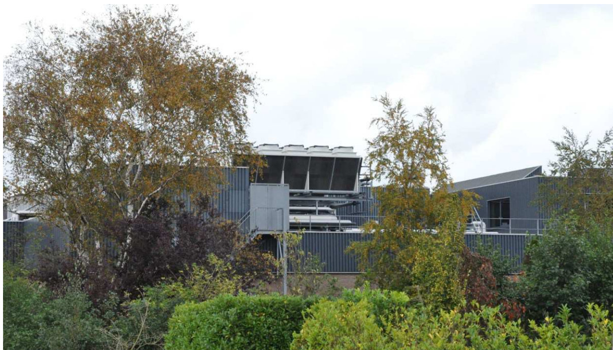
Foto: huidige situatie Zuidwest gevel gezien vanaf de N219.
