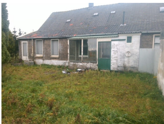
Foto 1: achterzijde woning, vanuit oostelijke richting
