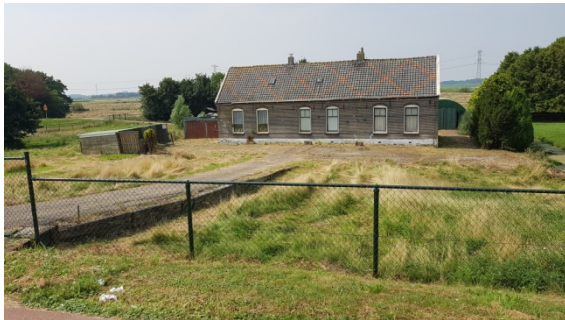
Foto 1: Voorzijde pand, vanuit oostelijke richting
