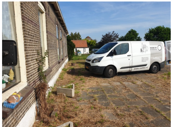
Foto 4: Onderzoekslocatie vanuit zuidelijke richting
