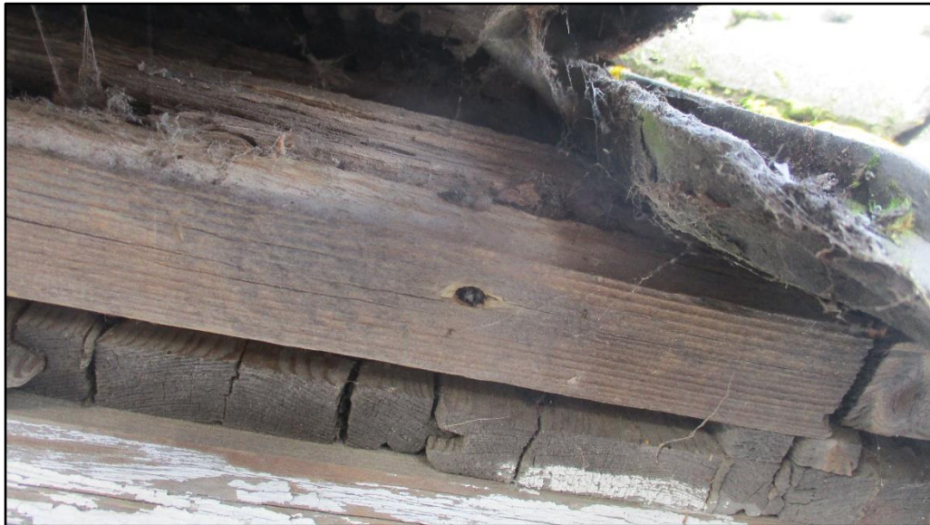
Figuur 5 Houten balken onder de pannen daken van de woning, waardoor huismussen geen toegang kunnen krijgen tot de dakruimte.
