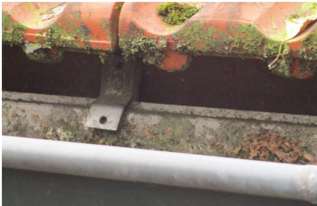
Figuur 5 De onderste rij dakpannen is ontoegankelijk voor huismussen.
