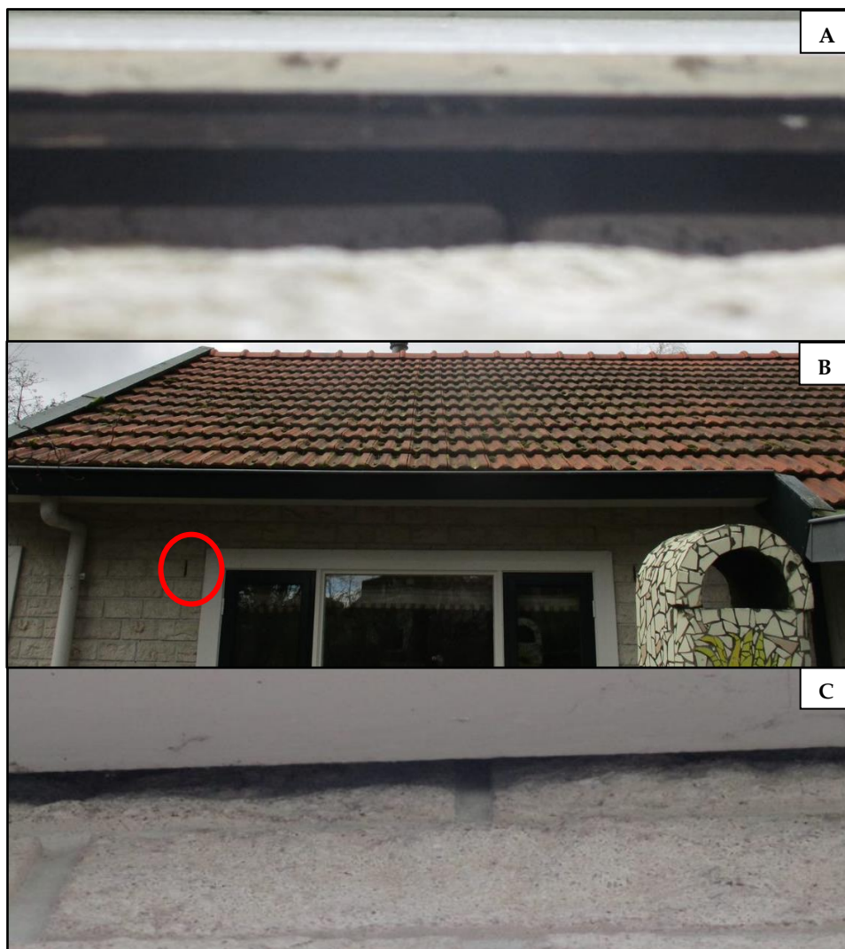
Figuur 4 Potentiële verblijfplaatsen voor vleermuizen. A) onder de gevelbetimmering; B) in de spouw via open stootvoegen; C) tussen gevel en dakoverstek.
