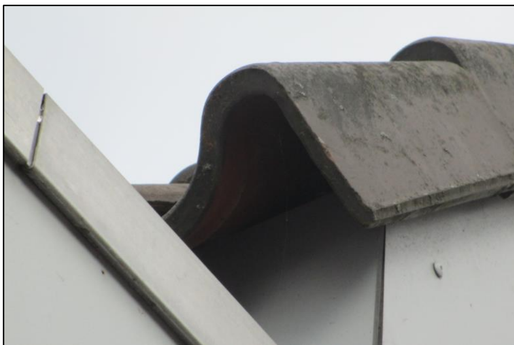
Figuur 6 Betimmering onder de dakpannen.
