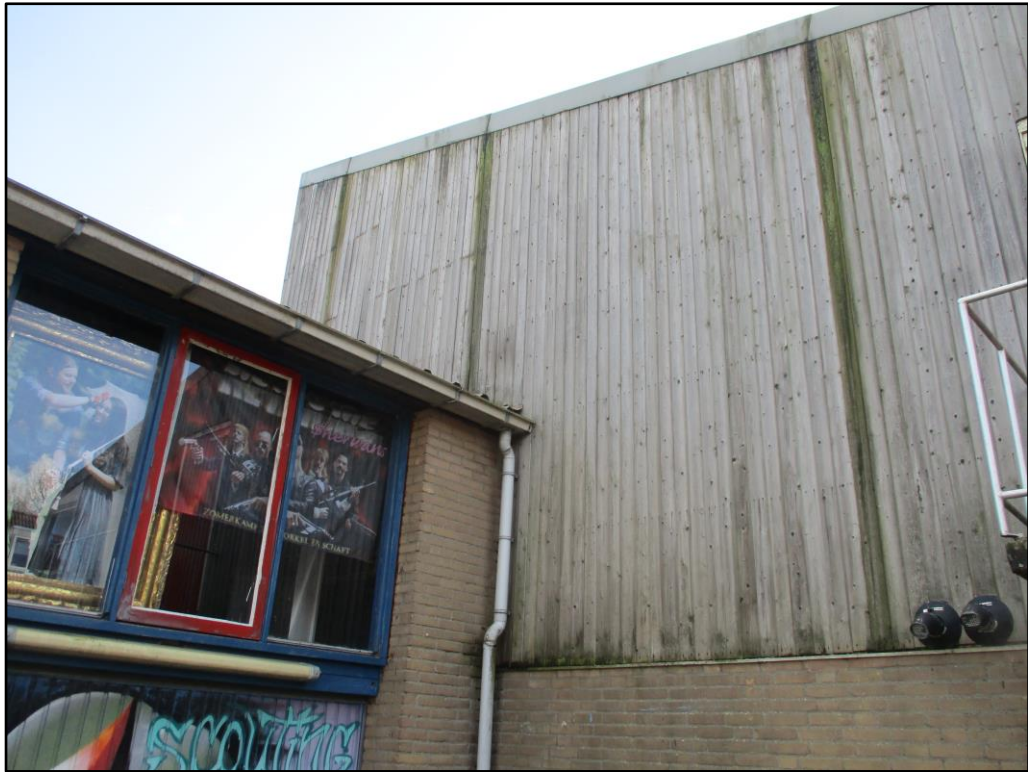
Figuur 3 De houten gevelbetimmering sluit nauw aan op de gevel, waardoor er geen geschikte invliegopeningen voor vleermuizen aanwezig zijn.
