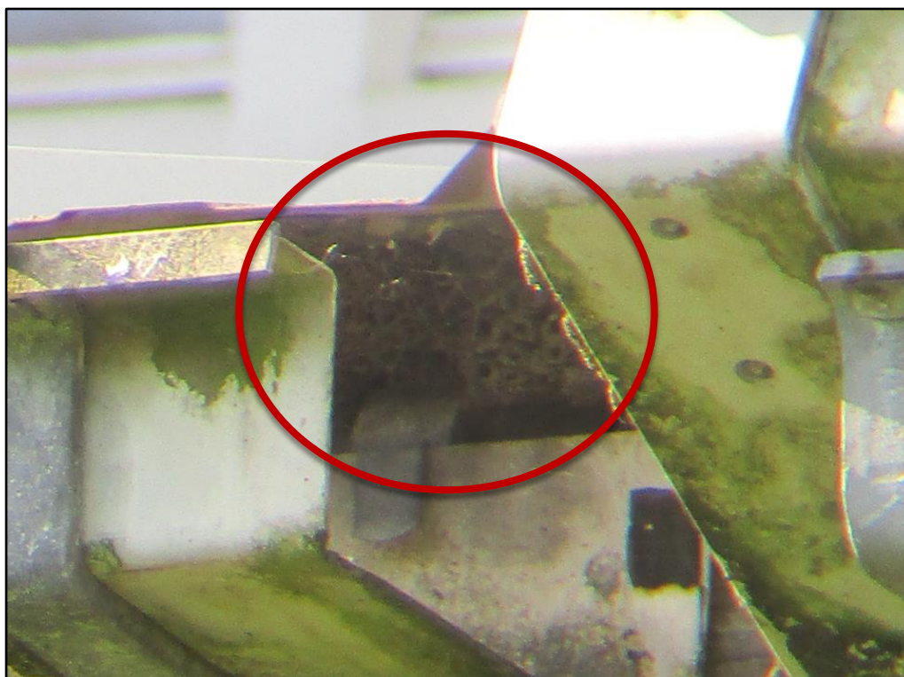
Figuur 3 De ruimte tussen het damwandplaten dak en het dakbeschot is gevuld met isolatiemateriaal.
