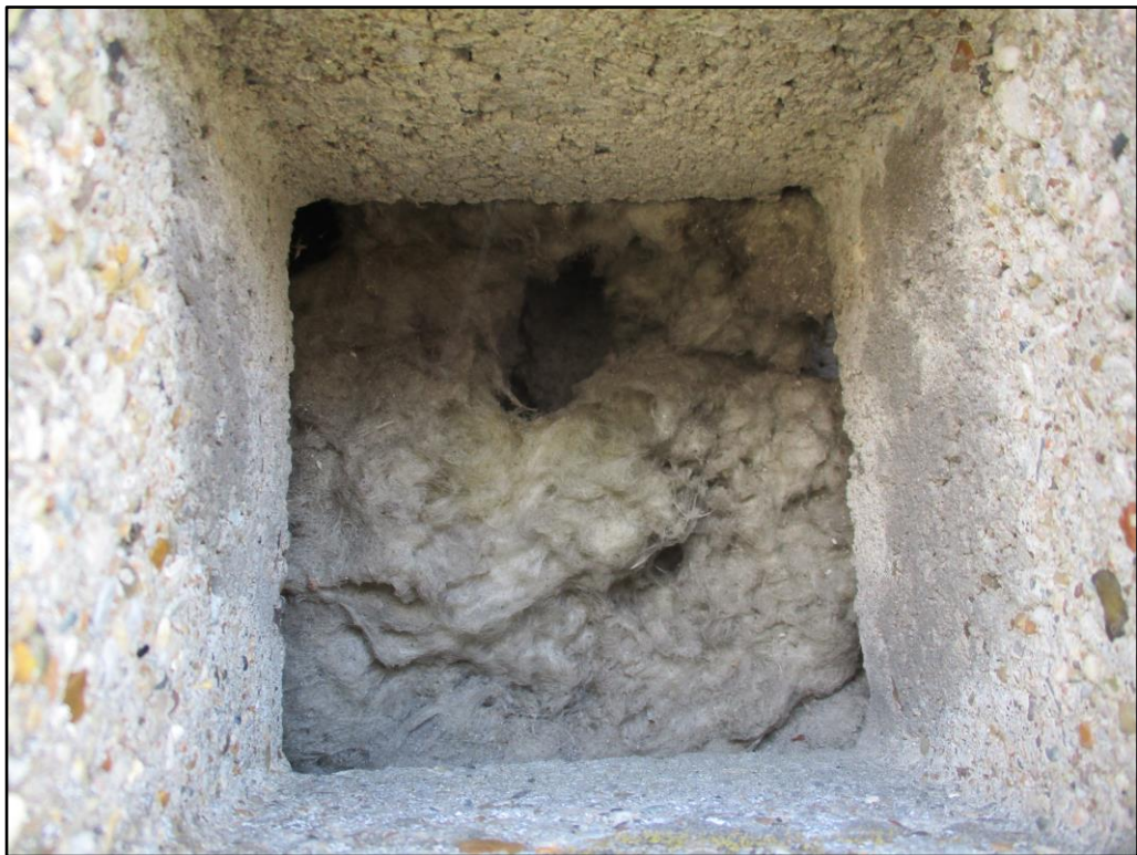
Figuur 4 De spouw is volledig gevuld met glaswol of steenwol, waardoor deze niet geschikt is voor verblijfplaatsen van vleermuizen.
