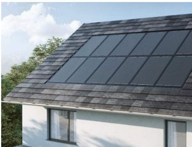
PV-panelen verzonken in het dak
