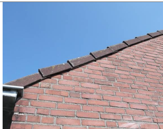
Foto 12: de dakranden worden niet gebruikt door vleermuizen, door de beperkte ruimte tussen pan en muur en hier is in alle gevallen veel spinrag aangetroffen.
