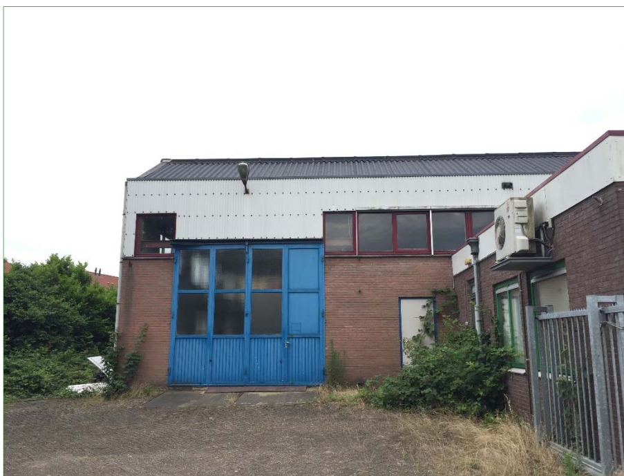
De leegstaande bedrijfshal in het plangebied.
