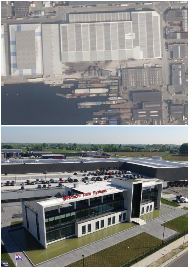
Figuur 7: Rutte Groep (boven; zonnepanelen) en Hitachi Vantara (onder; zonnepanelen en parkeren op het dak)
