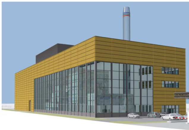
Figuur 4: Bio-energiecentrale Amsterdam
