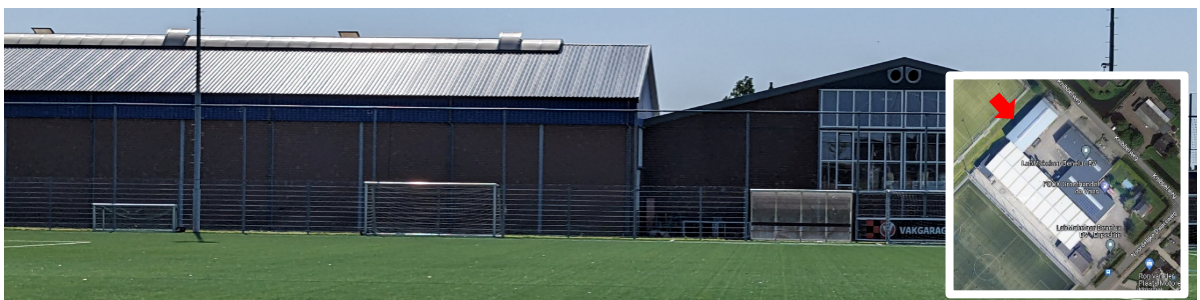
Figuur 3: Bedrijfshal Knibbelweg 18a – noordwest gevel (locatiebezoek 13 juni 2023)
