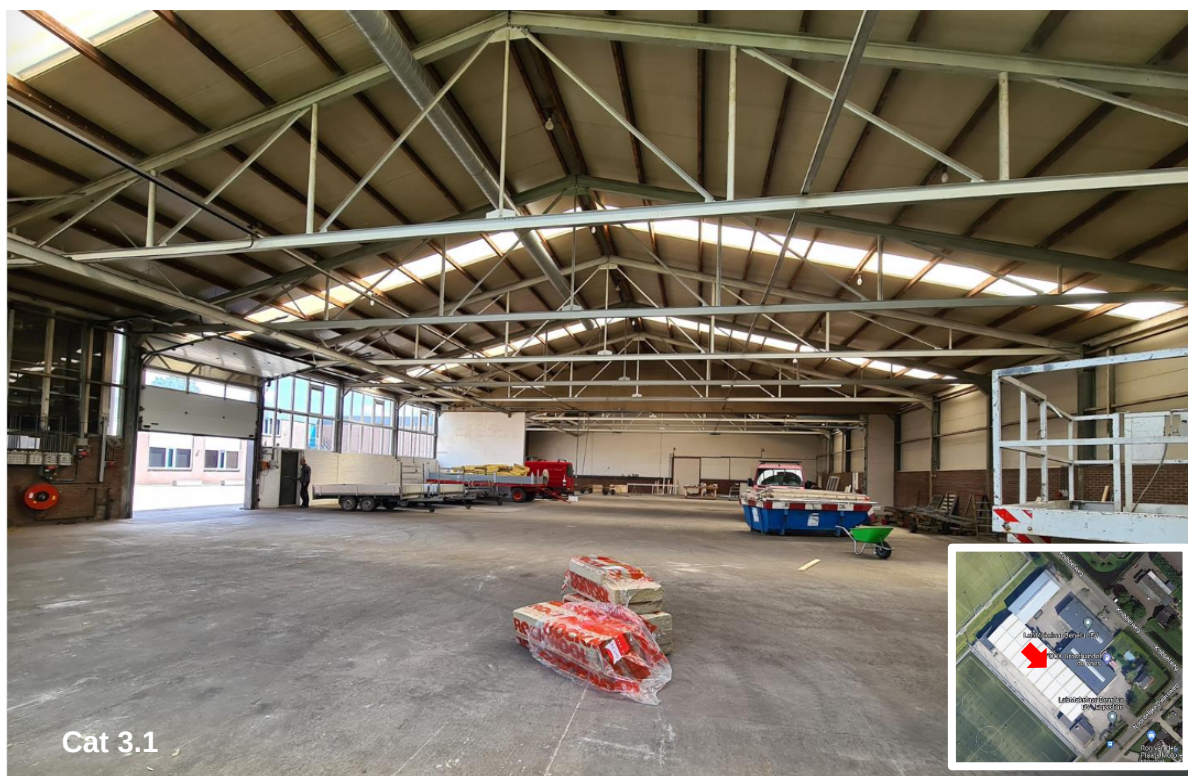
Figuur 1: Bedrijfshal Noordelijke Dwarsweg 49b – binnenzijde bedrijfshal richting kop zuidoost gevel (bron: https://ventu.nl/Bedrijfsruimte/Zevenhuizen/Knibbelweg/18a/7f2bba25-c61e-48b8-be18-b3eaffcaad86 )
