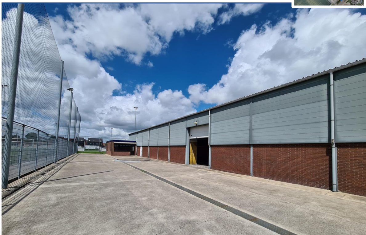
Figuur 3: Bedrijfshal Noordelijke Dwarsweg 49b – zuidoost gevel (locatiebezoek 13 juni 2023 en https://ventu.nl/Bedrijfsruimte/Zevenhuizen/Knibbelweg/18a/7f2bba25-c61e-48b8-be18-b3eaffcaad86 )
