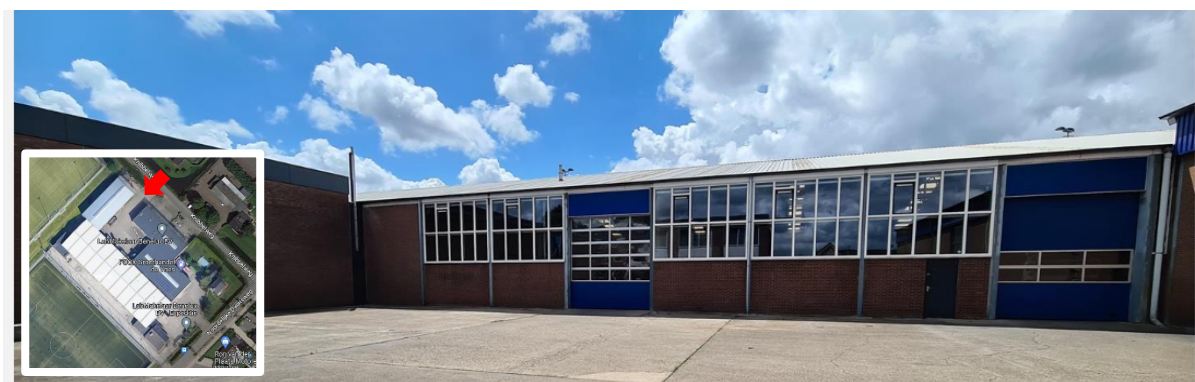
Figuur 6: Bedrijfshal Noordelijke Dwarsweg 49b – noordoost toegang (locatiebezoek 13 juni 2023 en https://ventu.nl/Bedrijfsruimte/Zevenhuizen/Knibbelweg/18a/7f2bba25-c61e-48b8-be18-b3eaffcaad86)) )
