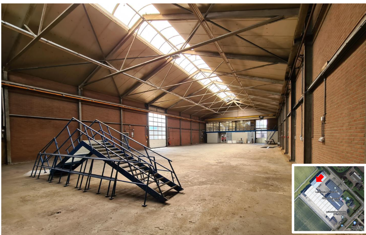
Figuur 2: Bedrijfshal Knibbelweg 18a – binnenzijde bedrijfshal richting kop zuidwest gevel (bron: https://ventu.nl/Bedrijfsruimte/Zevenhuizen/Knibbelweg/18a/7f2bba25-c61e-48b8-be18-b3eaffcaad86 )
