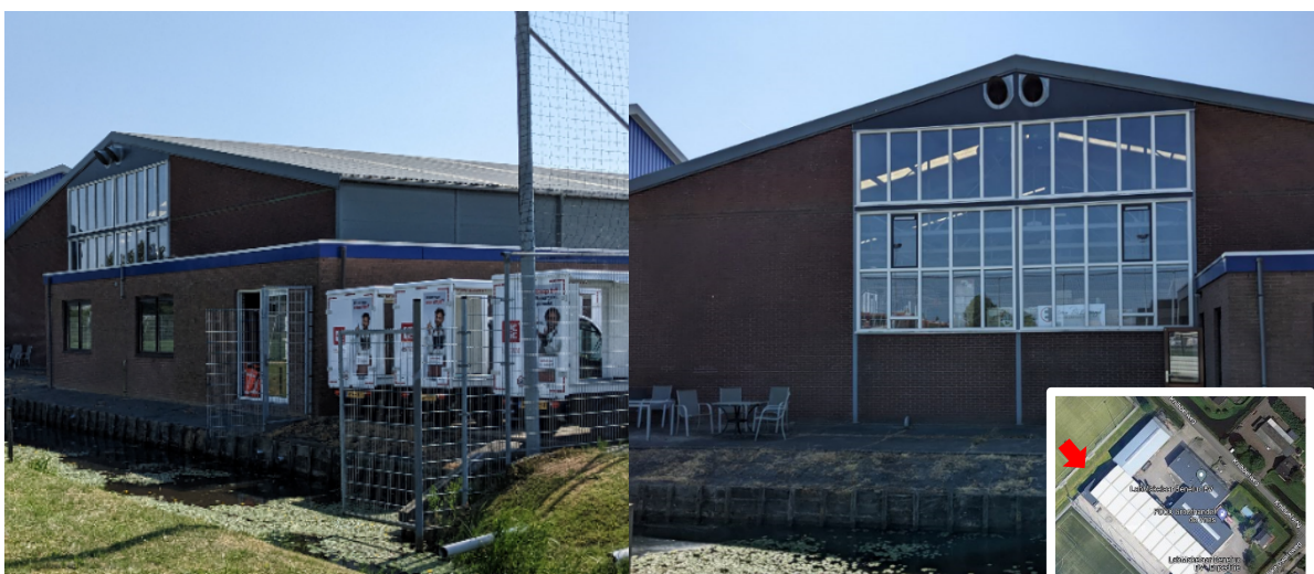
Figuur 4: Bedrijfshal Noordelijke Dwarsweg 49b – noordwest gevel (locatiebezoek 13 juni 2023)
