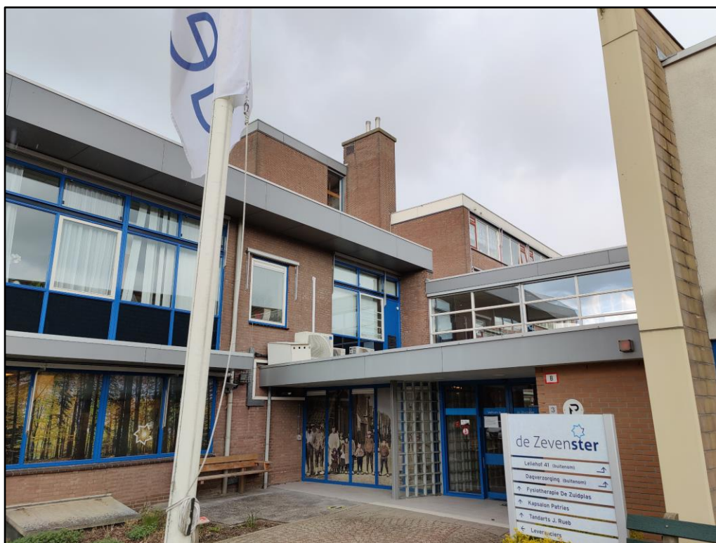
Figuur 3 Het verzorgingshuis De Zevenster maakt ook onderdeel uit van de planlocatie en bestaat uit meerdere, aan elkaar gekoppelde gebouwen. De bebouwing dient gesaneerd te worden binnen de beoogde ontwikkeling.
