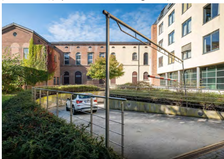
Toegang parkeerkelder onderdeel van gevelarchitectuur en/of inrichting (Bron: Parking Zwartzustersvest, David Legreve, Mechelen)
