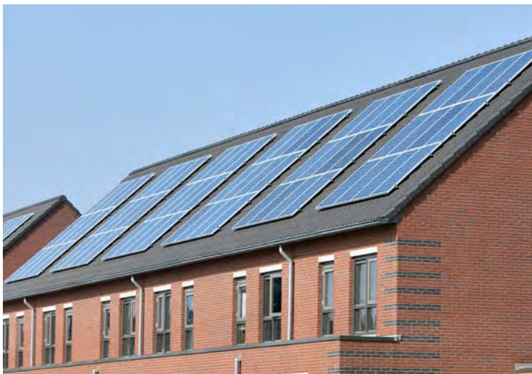
Evenwichtige inpassing zonnepanelen (Bron: TAUW, Energietransitie)
