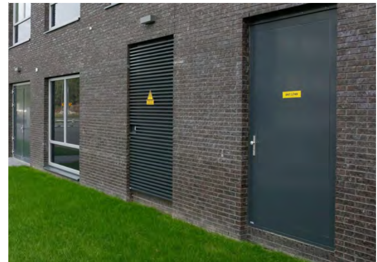
Bij voorkeur inpandige nutsvoorzieningen (Bron: Kenter, Inpandig Transformatorstation)
