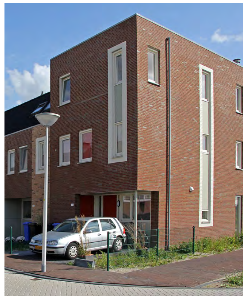
Ruimtelijk inspelen op de entree van de wijk (Bron: Arien CS, starterswoningen, Midden Delfland)
