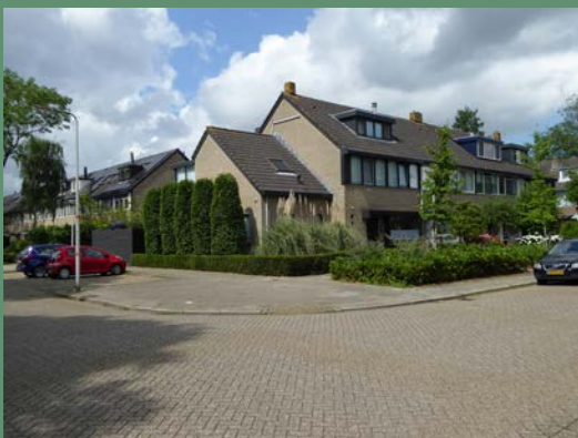
Bebouwing Kamerlingh Onnestraat
