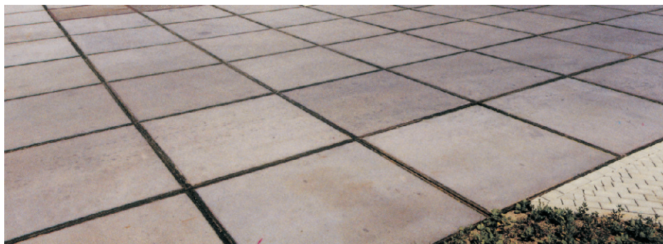
betonplaten, (donker) grijs
