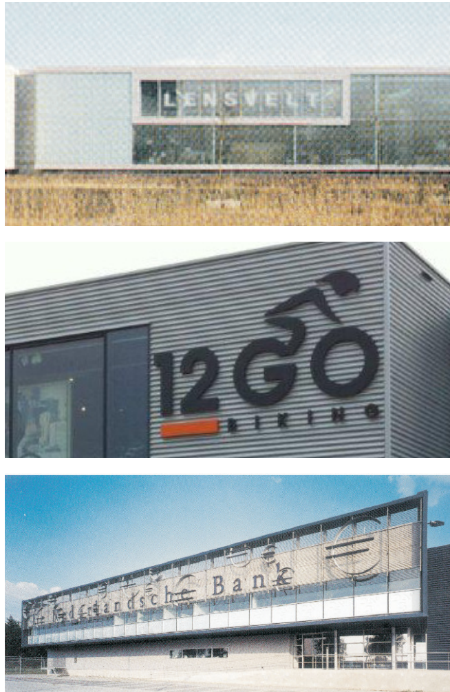
Figuur 7 voorbeelden reclame op gevel
