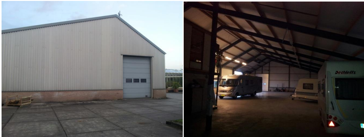
Figuur 2 Impressie van de te slopen loods
