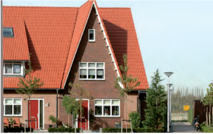
Onderverdeelde gevelopeningen met een staande verhouding
