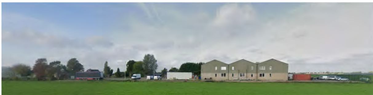
Bestaande situatie BHW 27 zoals gezien vanaf de Zuidelijke Dwarsweg (Google maps streetview)
