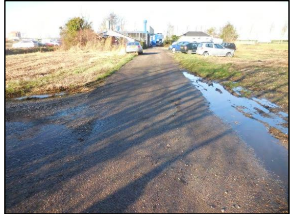
Foto 20: Asfaltverharding westelijk terreindeel
