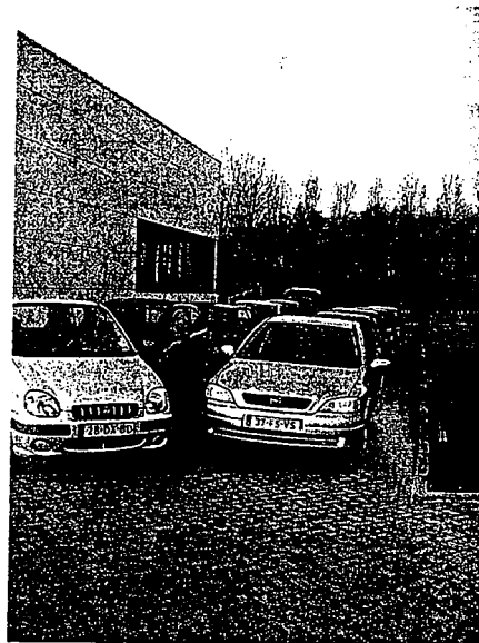
Foto 2: De zijkant van het pand (noordoostzijde). Hier zal een toegang naar de nieuwe showroom worden gebouwd.
