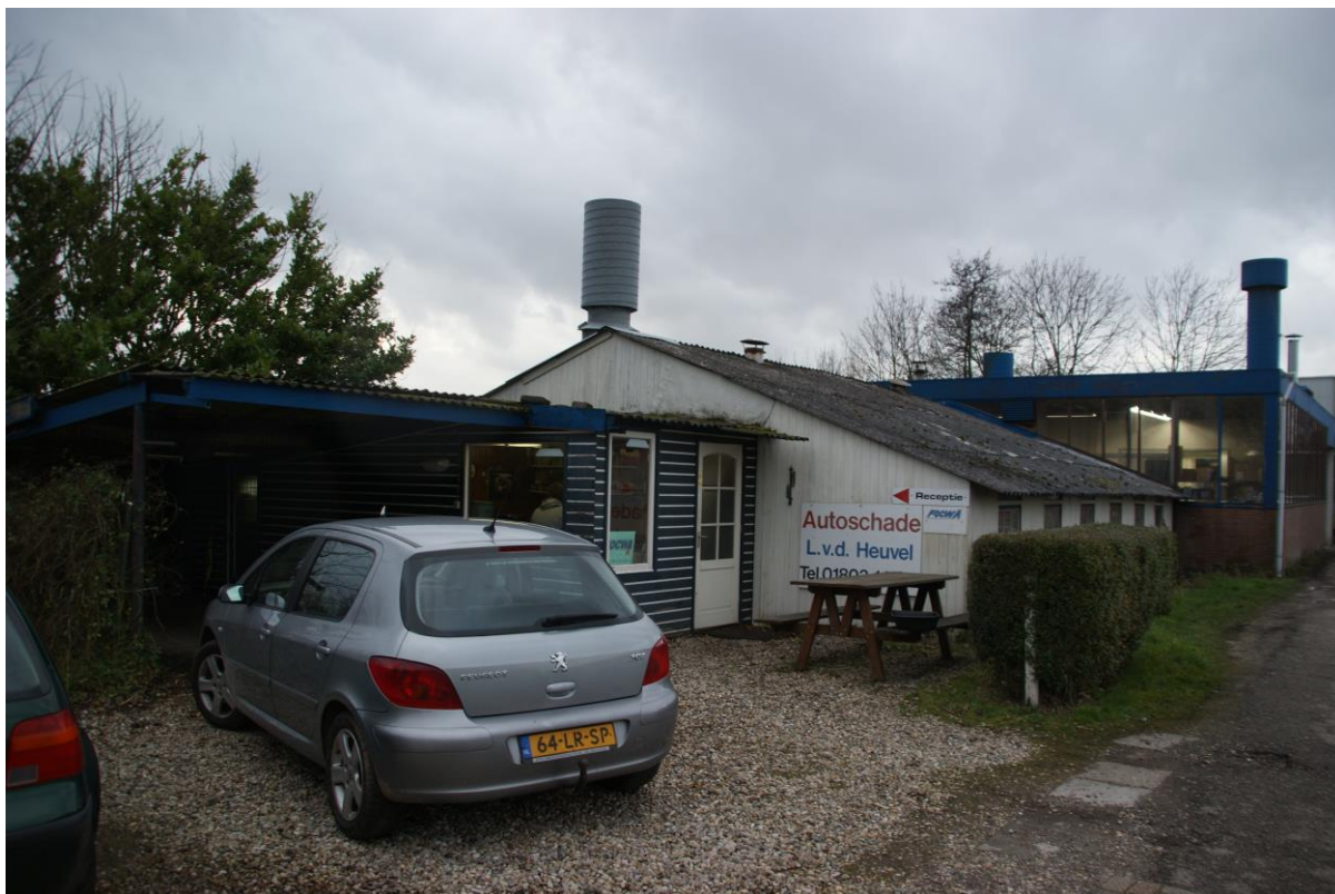
Figuur 10.2: de te slopen bedrijfsgebouwen in het plangebied
