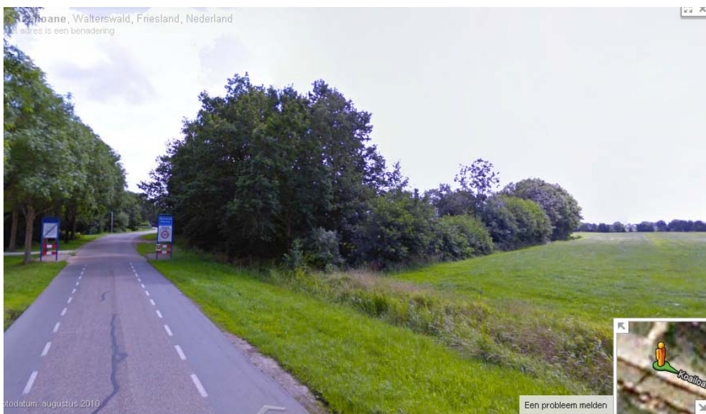
Foto bestaande erf vanaf de westzijde (Bron: Google Maps, Streetview, 2013)
