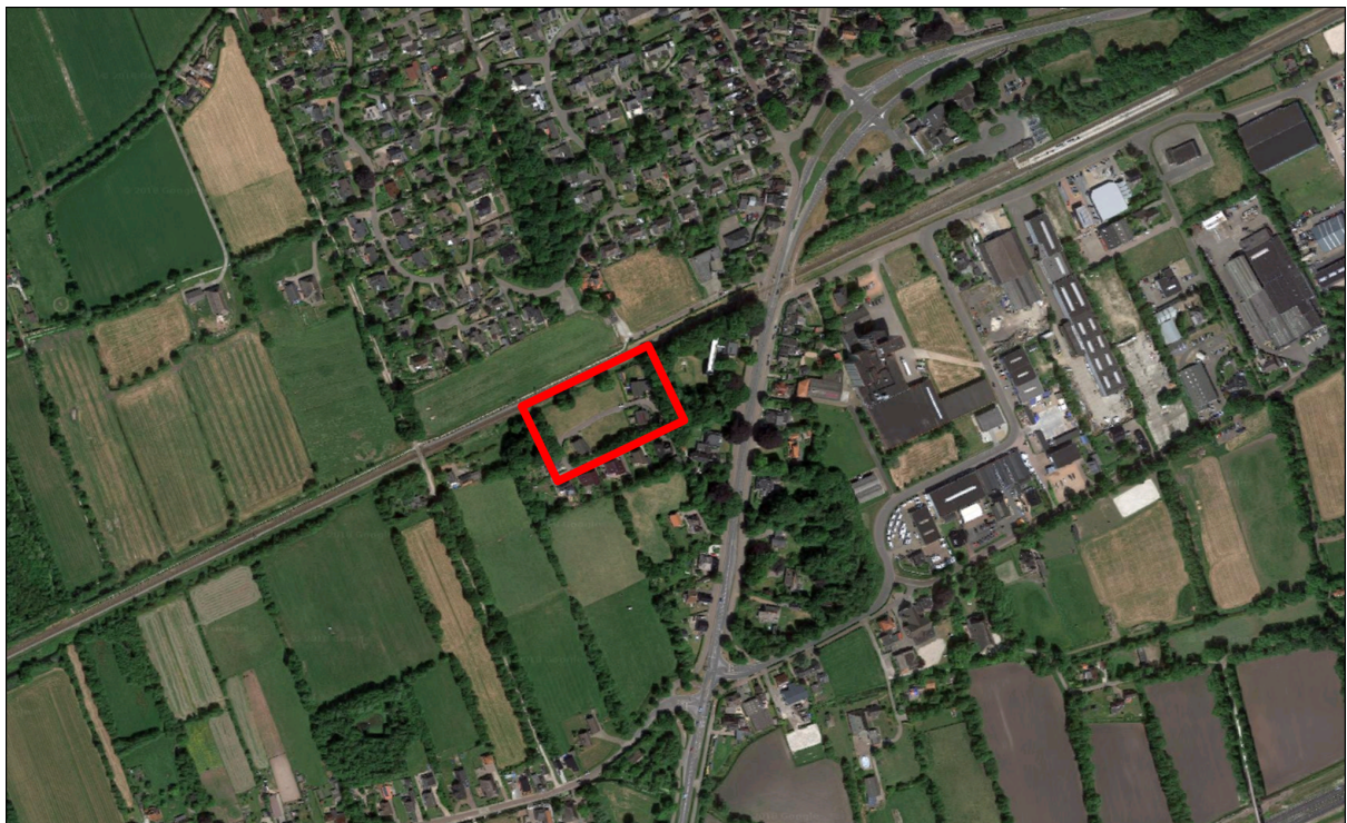
Afbeelding 2. Luchtfoto aanwezige bebouwing (Google Maps, d.d. 18 september 2018)
