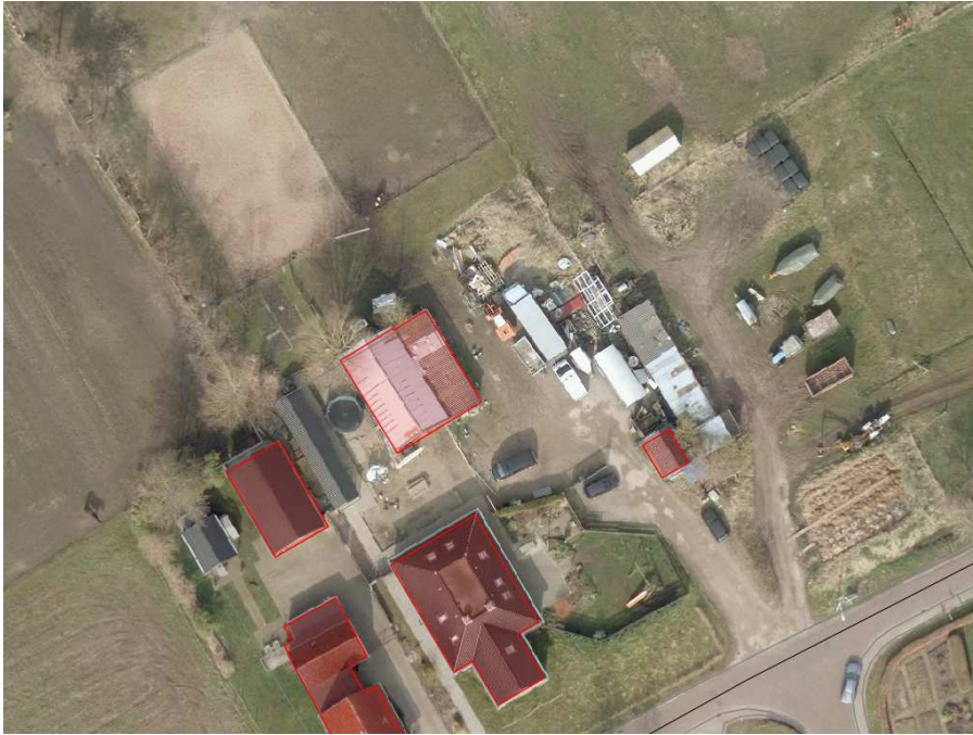
Figuur 5 Luchtfoto De Swette 41: door opslag / parkeren geringe ecologische waarde van bouwlocatie
