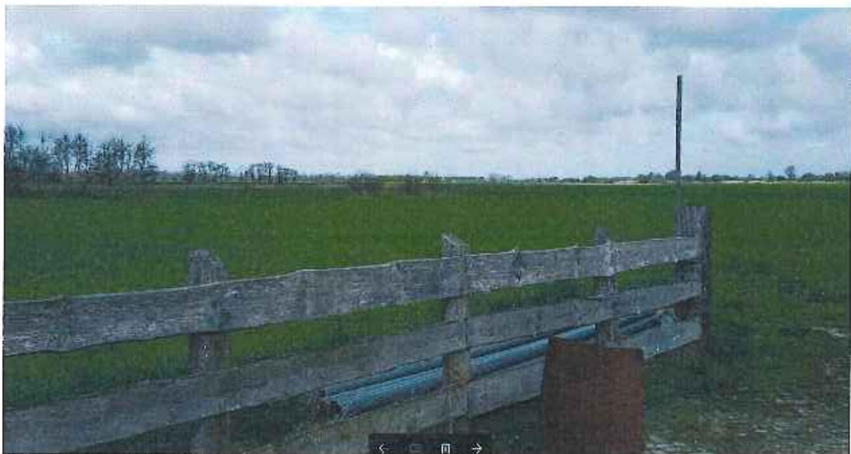
Noordwestzijde (hekwerk als bedoeld voor afscheiding)
