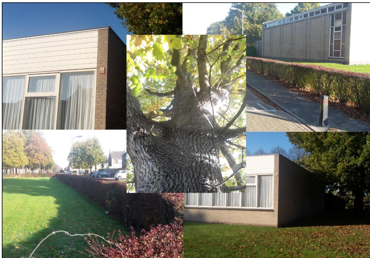
Figuur 1. Impressie geïnspecteerde delen van het plangebied De Westereen (november 2016)
