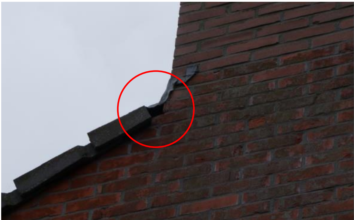
Figuur 5-2: ruimte onder loodslab bij schoorsteen (rood omcirkeld). Deze ruimte biedt toegang voor vleermuizen en gierzwaluwen.
