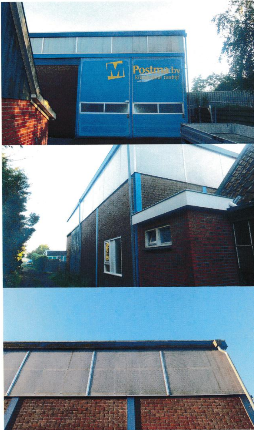
Foto's 1, 2 en 3 (A&W 2015). De vierkante loods die gesloopt gaat worden. De loods is geheel dicht en de polycarbonaatbeplating en boeidelen sluiten strak aan op het gemetselde deel. De schuur rechts op de voorgrond (foto 2) blijft behouden.
