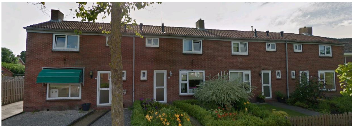
Figuur 2-3 Voorzijde woningen Nijewei 22-28 te Damwoude (Bron: Googlemaps)
