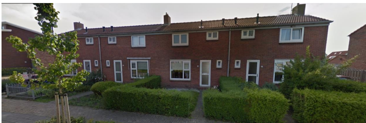
Figuur 2-4 Voorzijde woningen Nijewei 30-36 te Damwoude (Bron: Googlemaps)
