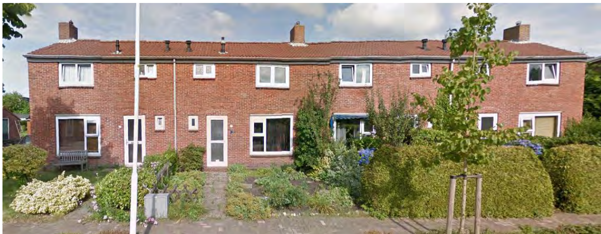
Figuur 2-2 Voorzijde woningen Nijewei 23-29 te Damwoude (Bron: GoogleMaps)
