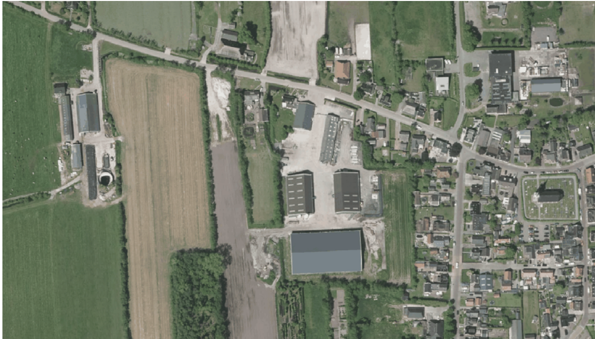
Figuur 1: Overzicht terrein Loonbedrijf D. van der Beek Driesum
