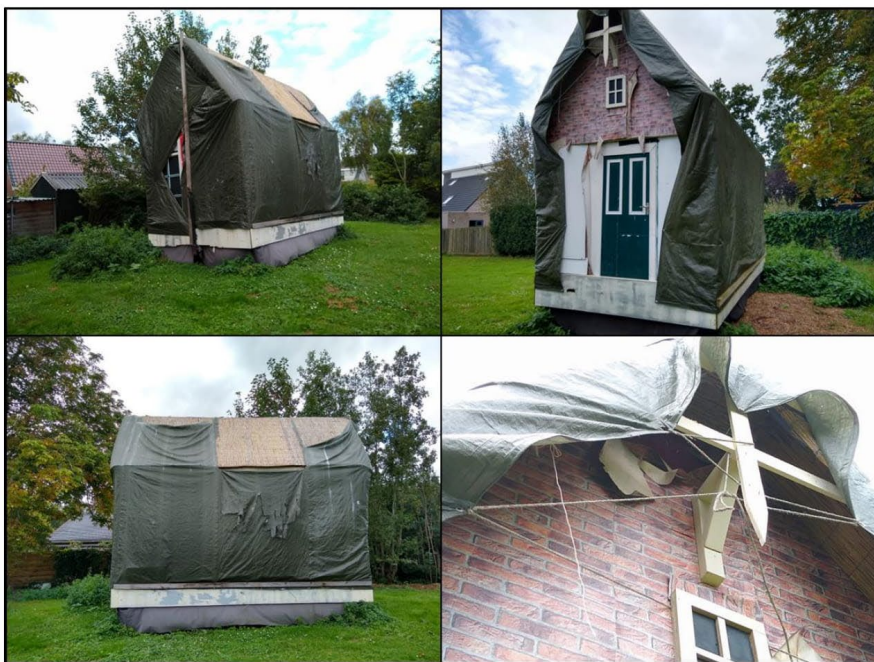
Figuur 2.2 De stacaravan beschikt over een rieten dak waar een zeil over is gespannen.
