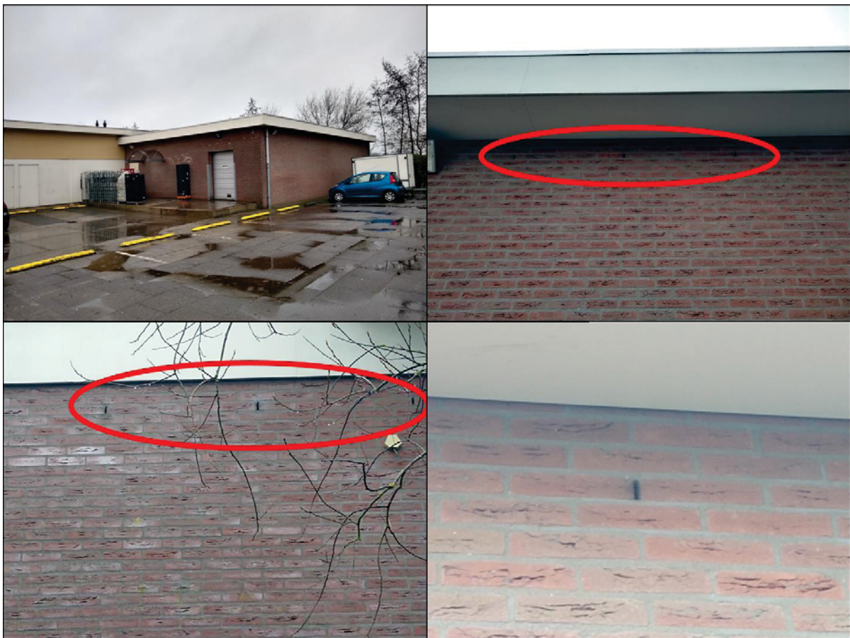
Figuur 2.3. Stootvoegen rond een aangebouwde ruimte aan de oostzijde van de bestaande supermarkt.
