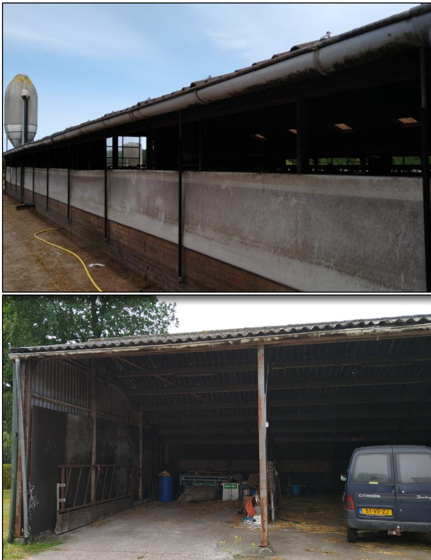
Figuur 1.2.: een impressie van de te slopen bebouwing in het plangebied.
