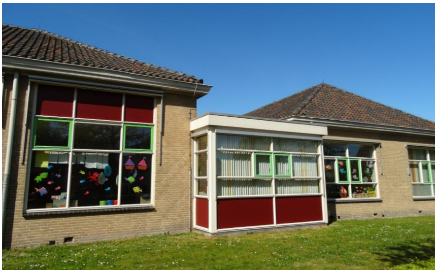
Figuur 2: Zijgevel schoolgebouw gezien vanaf de Nijewei.
