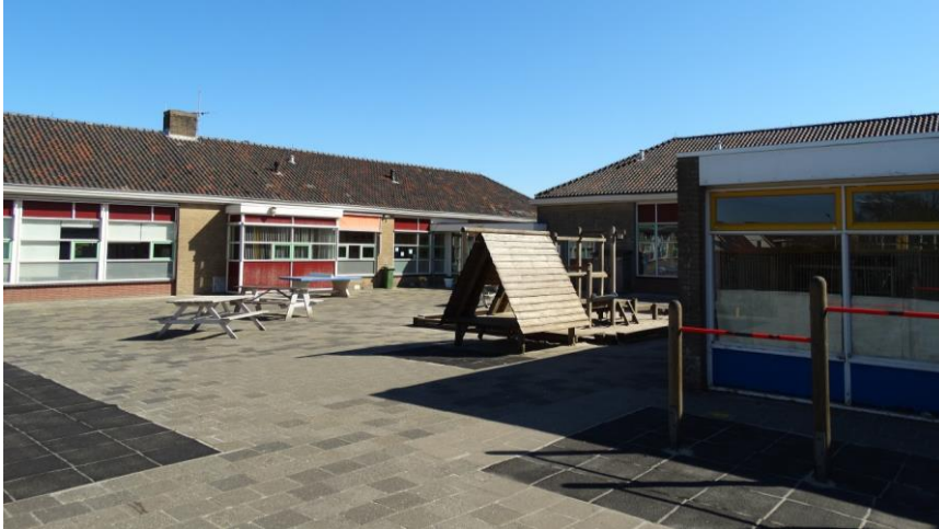
Figuur 4: Schoolgebouw gezien vanaf schoolplein in noordoostelijke richting kijkend.
