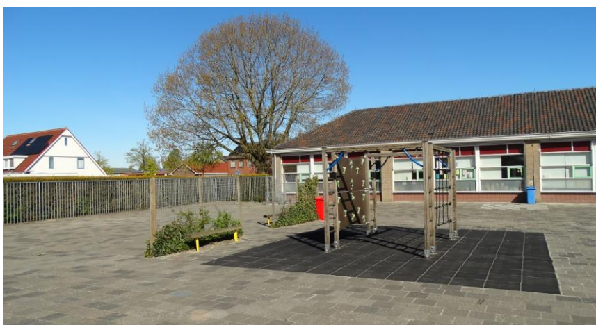
Figuur 3: Schoolgebouw gezien vanaf schoolplein in noordelijke richting kijkend.
