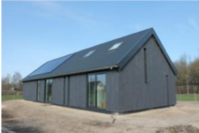
Voorbeeld van een schuurwoning
