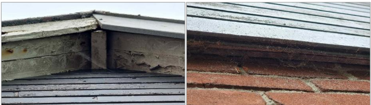
Afbeelding 4. Tussen daklijsten, houten gevelbekleding en muurconstructies van de woning en schuur zijn geen geschikte in- en uitvliegruimtes aanwezig voor vleermuizen.
