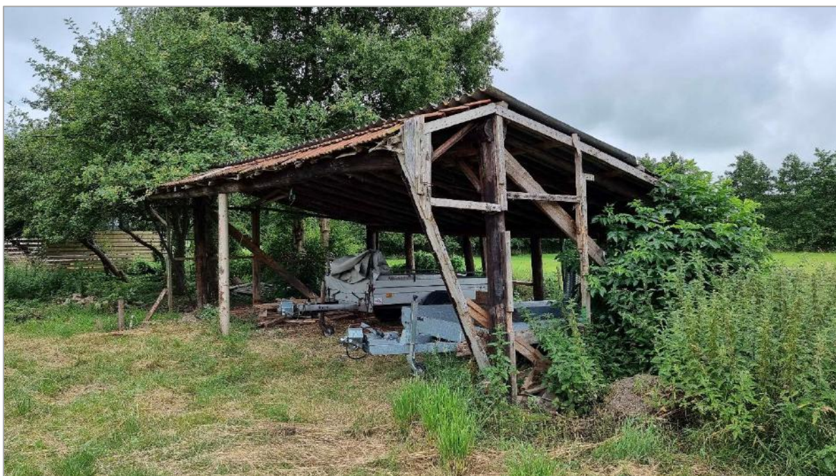
Overkapping ter plaatse van de toekomstige woning. Foto richting zuiden.
