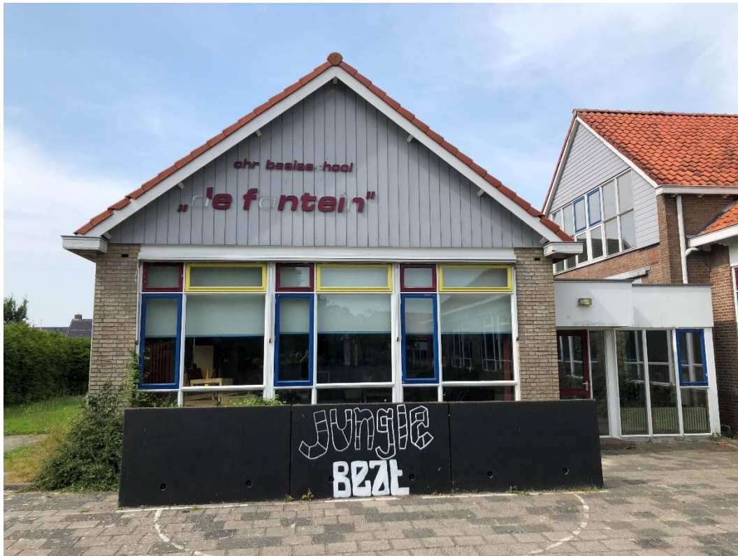
Figuur 2.4 Zuidgevel bouwdeel A, lage corridor is bouwdeel B en helemaal rechts de westgevel van bouwdeel C.
