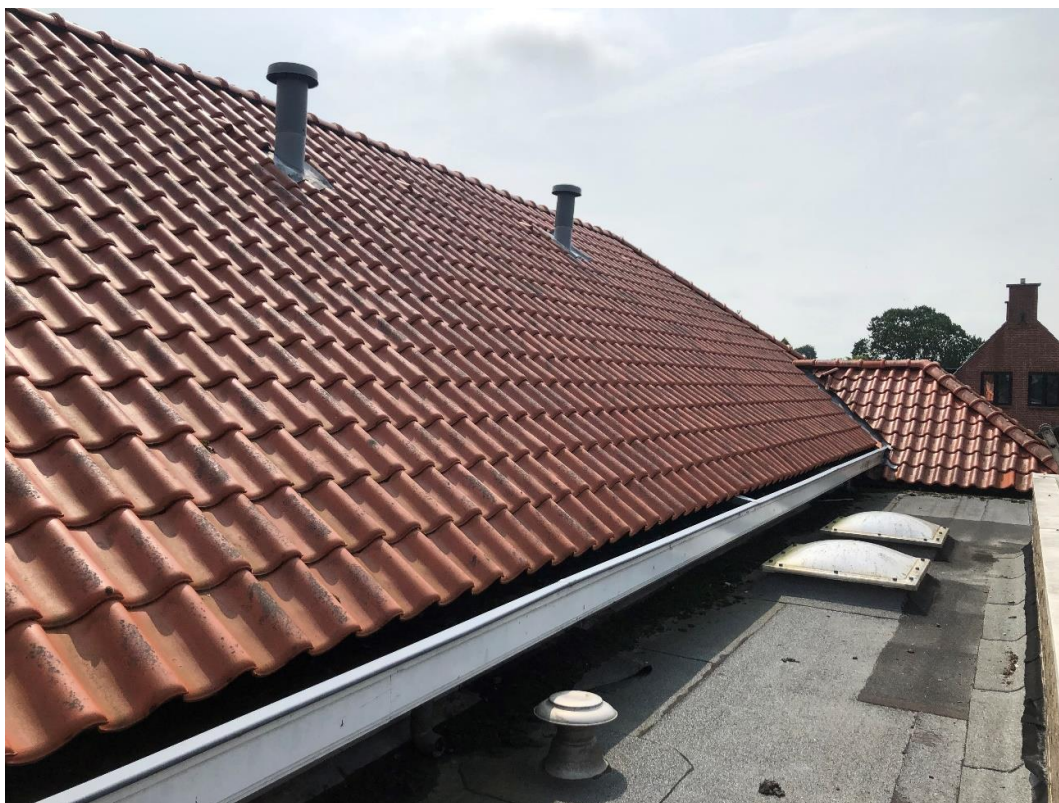
Figuur 1.7 Noordelijk dakvlak van gebouwdeel G
