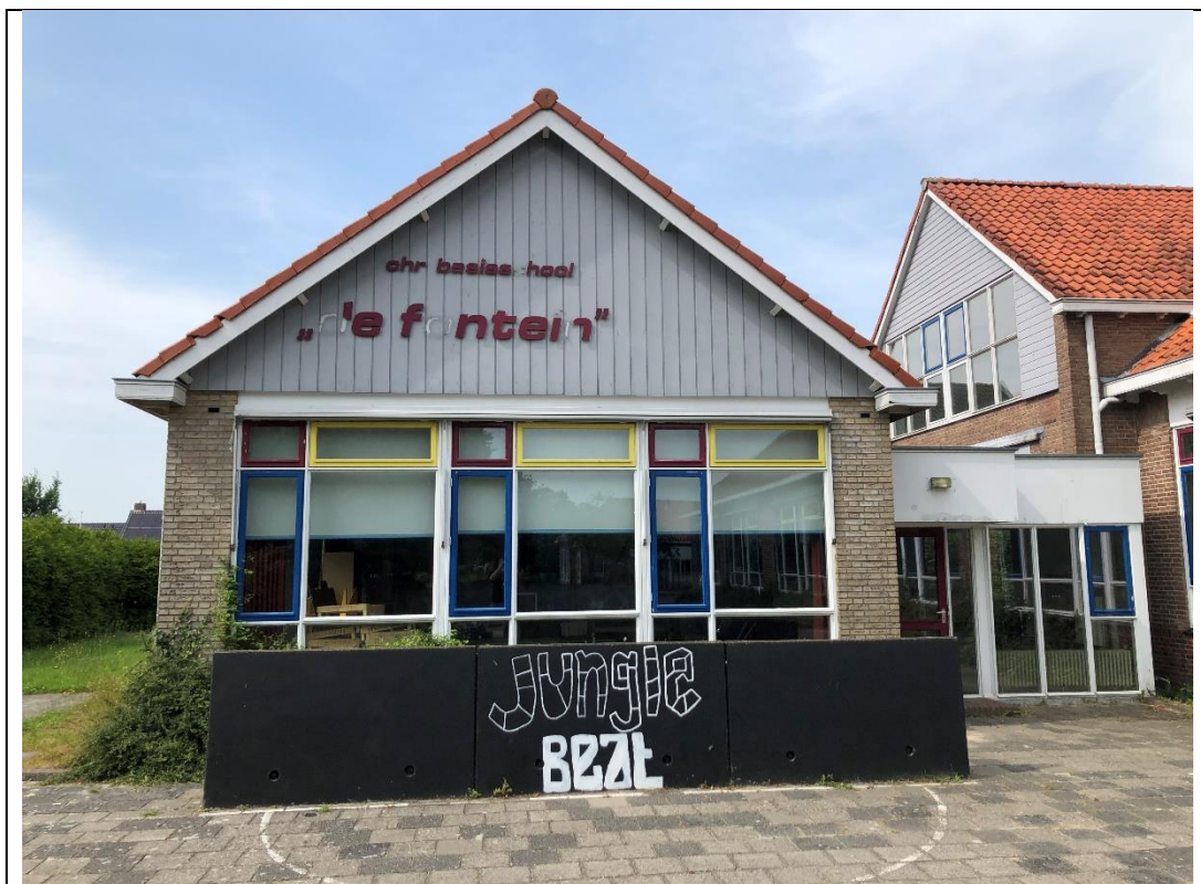
Figuur 1.4 Zuidgevel bouwdeel A, lage corridor is bouwdeel B en helemaal rechts de westgevel van bouwdeel C.
