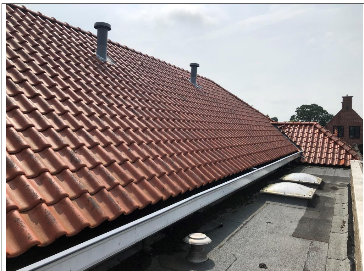
Figuur 1.7 Noordelijk dakvlak van gebouwdeel G
