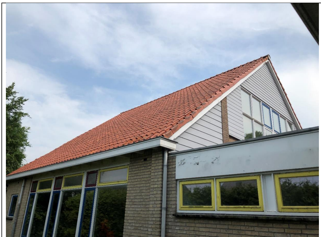
Figuur 1.5 Noordgevel van bouwdeel C.
