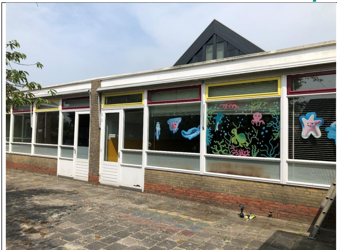
Figuur 1.6 Westgevel van gebouwdeel F.
