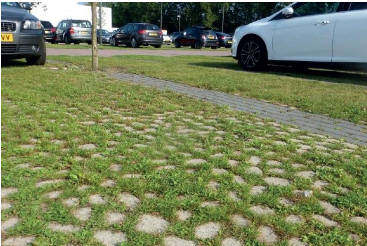
Figuur 9. Keigrasstenen een groen uitstraling en opvang/afvoer van hemelwater.
