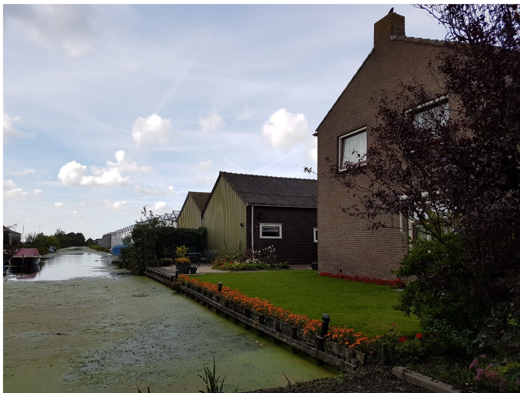
Figuur 1 De planlocatie is gelegen aan Zuideinde 112 te Roelofarendsveen. Het schuur- en kassencomplex wordt gesaneerd. Rondom de planlocatie zijn brede veensloten aanwezig met een onnatuurlijke oeverzone.
