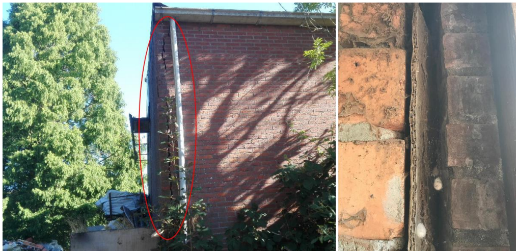
Figuur 2 De spouw is 35 a 40 mm diep en gevuld met een isolerende gegolfde folie. Deze folie is ca. 8 a 10 mm dik.
