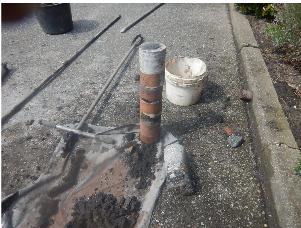
Figuur 39: Baksteenlaag onder het asfalt in boorprofiel 1.
