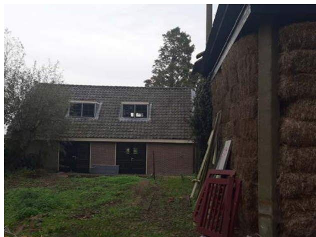
Afb. Gemetselde schuur met pannendak uit 1954 die een eerdere voorloper uit 1895, die ongeveer op dezelfde plaats stond, heeft vervangen.
