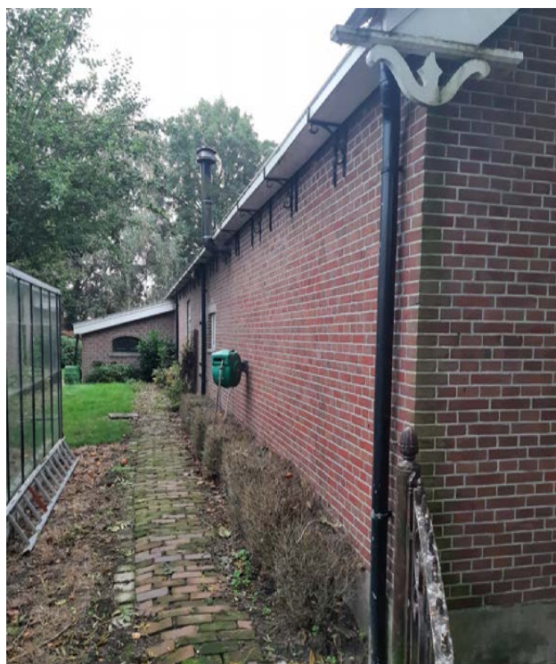
Afb. Rechtergevel van het zomerhuis. Ter plaatse van het voormalige stalgedeelte zijn twee boven-en onderdeuren aanwezig.
