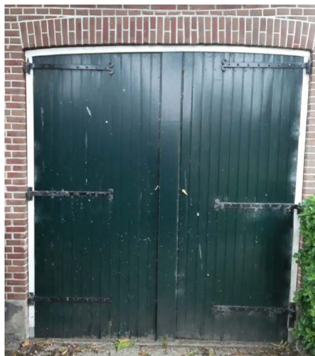
Afb. Achtergevel van het zomerhuis. Staldeur (vernieuwd) die toegang gaf tot de voormalige wagenschuur.
