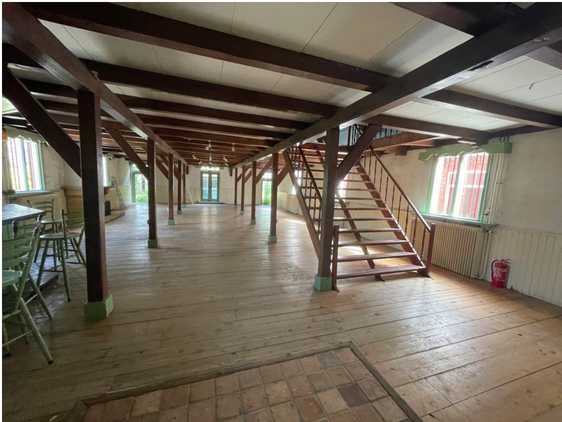
Afb. Draagconstructie uit de bouwtijd van de verdiepingsvloer in achterhuis. De zolderbalken zijn om en om voorzien van sleutelstukken. De trap(sparing) is in een secundaire bouwphase ingebracht.
