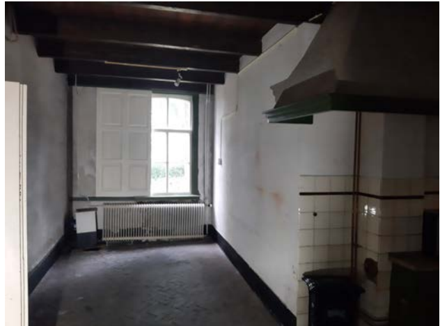
Afb. Draagconstructie uit de bouwtijd; de verdiepingsvloer ter plaatse van de werkkeuken. Het schuifvenster met schuifluiken bevindt zich in de voorgevel van het zomerhuis
