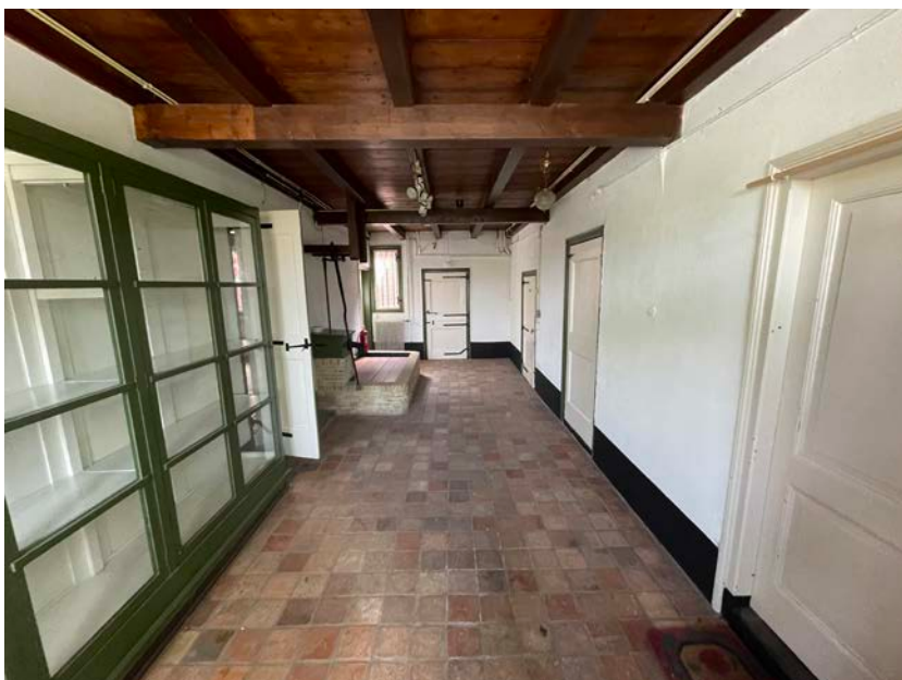
Afb. Werkkeuken in voorhuis kijkend richting het zomerhuis. Rechtsvoor op de foto de deur naar de woonkamer, in het midden rechts de deur naar voormalige opgang naar de zolderverdieping boven het voorhuis. Daarachter de kelderdeur. In het midden van de foto de boven-en onderdeur naar de werkkeuken in het zomerhuis. Links op de foto is nog de dubbele deur zichtbaar ter plaatse van de voergang met daarachter de pomp.
