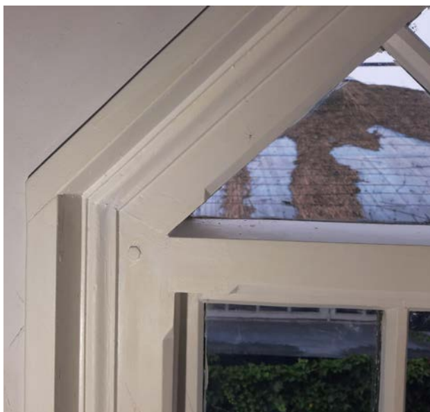
Afb. Binnenkant keperboogvenster. Duidelijk zichtbaar is de houten toognagel en de biljoening van het kozijnhout. De dagkantbetimmeringen dateren uit een secundaire bouwphase (XXa).
