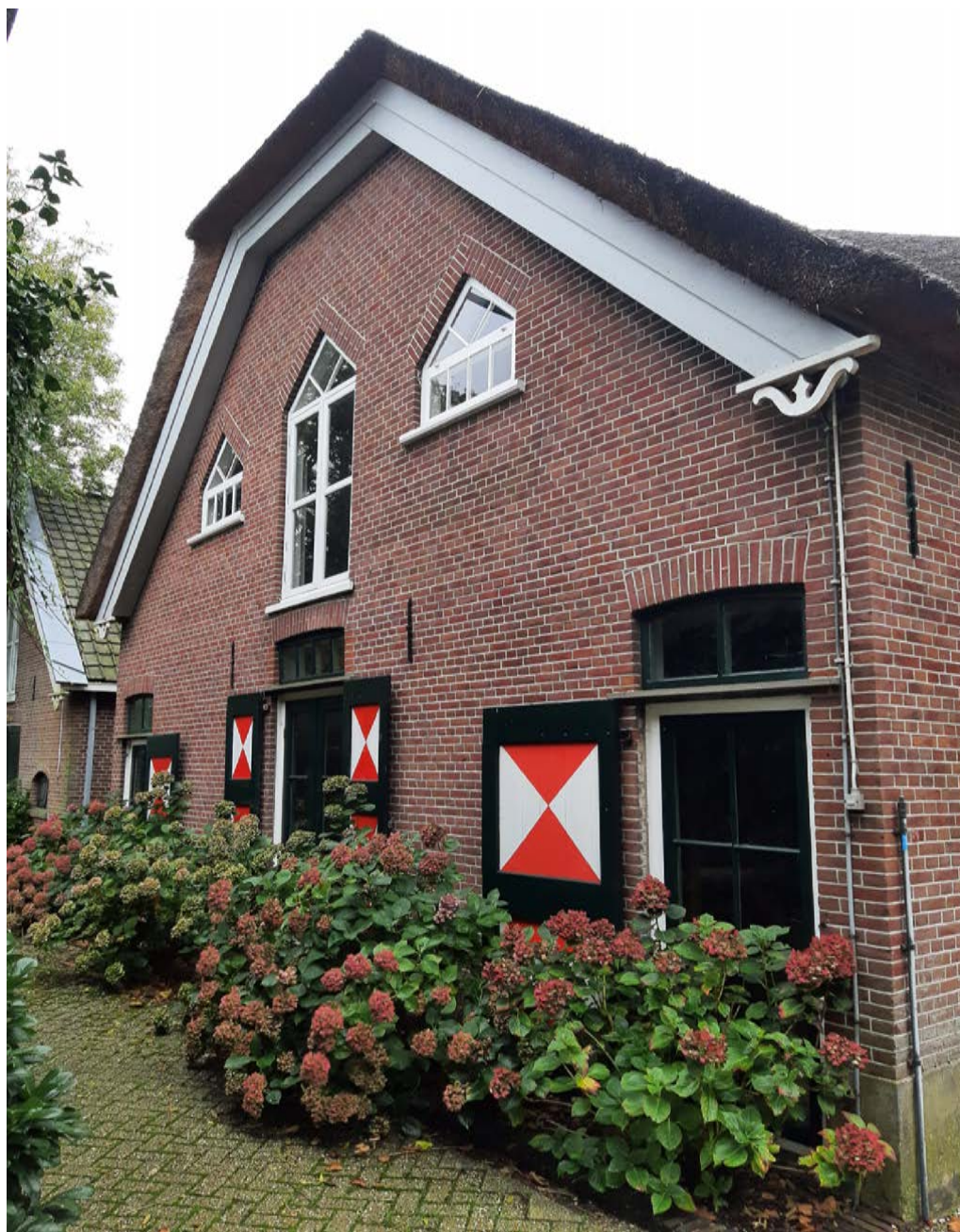
Afb. Achtergevel boerderij.
