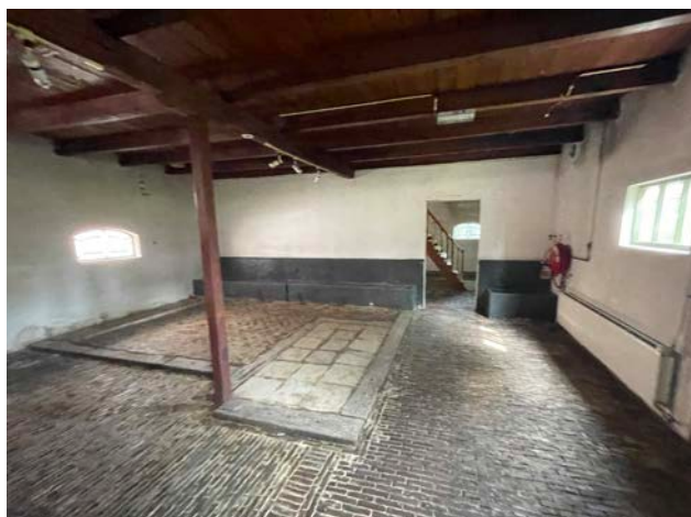
Afb. draagconstructie uit de bouwtijd; de verdiepingsvloer ter plaatse van stalgedeelte in het zomerhuis. De wandopening dateert uit een secundaire bouwphase en geeft toegang tot de voormalige wagenschuur
