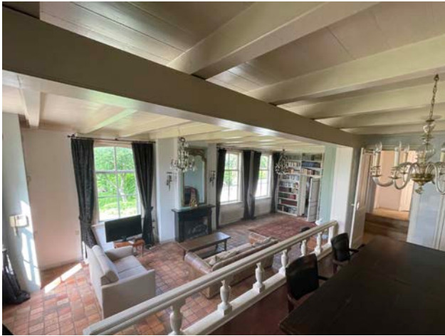
Afb. Draagconstructie uit de bouwtijd van de verdiepingvloer in het voorhuis. De (dragende) scheidingswand tussen opkamer en woonkamer is in een secundaire gebruiksfase weggebroken.
