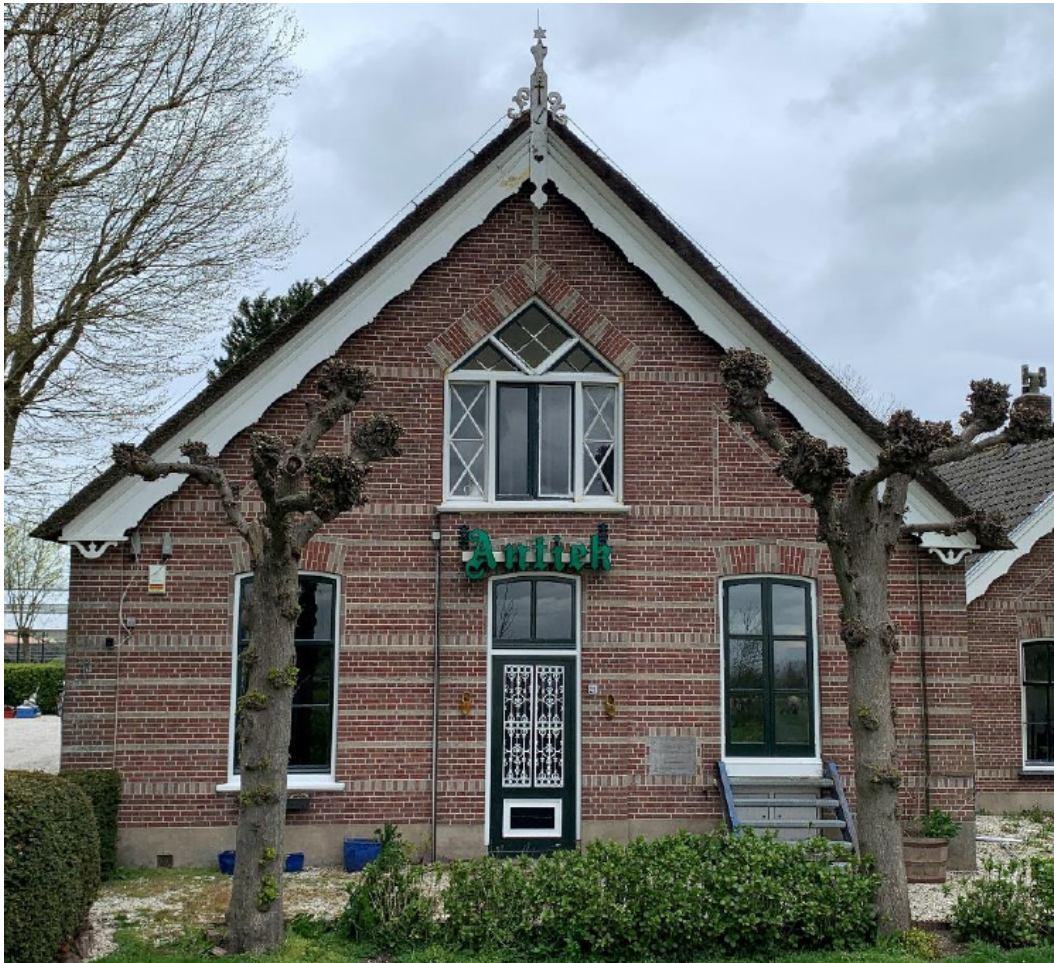
Afb. Voorgevel boerderij. Duidelijk zichtbaar is het siermetselwerk in een contrasterende kleur. Een de geveltop een metselteken in de vorm van een Latijns kruis.
