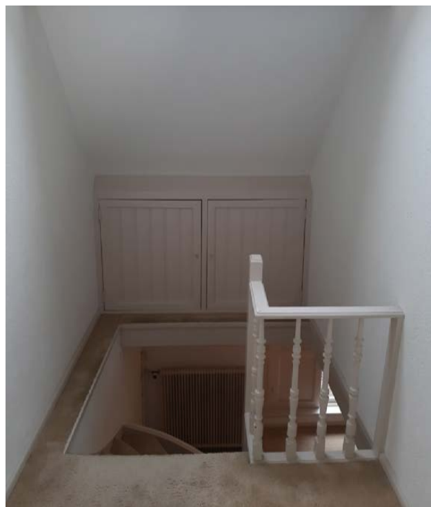
Afb. Nieuwe trapsparing en trap (XXd/XXIa) tussen het voormalige slaapvertrek in het voorhuis en de zolderverdieping. De oorspronkelijke opgang naar de zolder was via een laddertrap vanuit de werkkeuken.
