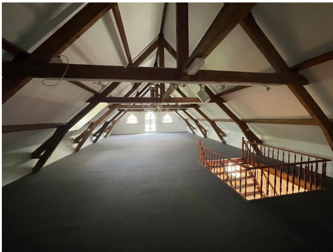
Afb. Zolderverdieping boven het voormalig stalgedeelte in achterhuis. De oorspronkelijke kappanten en gordingen zijn grotendeels nog aanwezig. De sporen en het dakbeschot zijn niet zichtbaar door een aftimmering met houtvezelplaten. Na een schoorsteenbrand in 2018 is de rietbedekking boven het stalgedeelte vernieuwd. Sporen van de brand en herstellingen zijn nog zichtbaar op de spanten in het laatste travee aan de achtergevel. Waarschijnlijk is ook (een deel van) de sporen en het dakbeschot vernieuwd.
