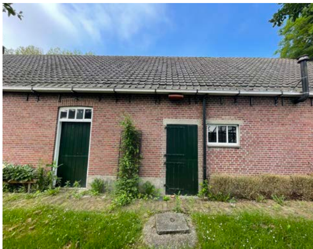
Afb. Rechtergevel van het zomerhuis. Ter plaatse van het voormalige stalgedeelte. Links de boven-en onderdeur uit de bouwtijd, rechts daarvan een in een secundaire bouwphase bijgeplaatste deur met zijraam.
