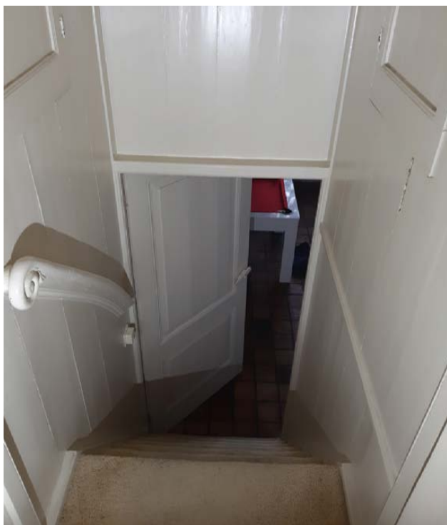
Afb. Trap en opgang (1887) tussen de woonkamer en het voormalige slaapvertrek op de tussenverdieping in het voorhuis.
