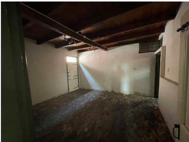
Afb. links Draagconstructie uit de bouwtijd; de verdiepingsvloer ter plaatse van de voorruimte van het stalgedeelte in het zomerhuis.
