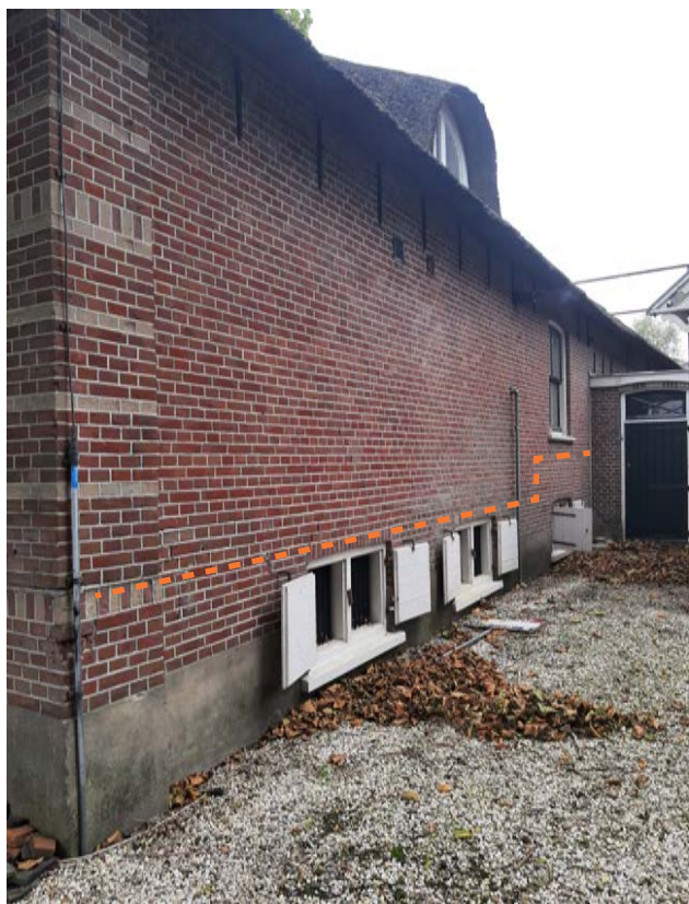
Afb. Rechter lansgevel van de boerderij ter plaats van het voorhuis (opkamer en melkkelder) met tweedelige keldervensters voorzien van luikspionningen, dievenijzers en houten luiken (vernieuwd XXB). De oranje stippellijn geeft het verloop van de kelderzoldering aan.
