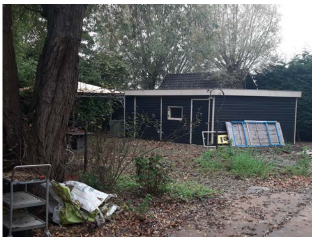
Afb. Diverse bouwsels links achter op het perceel. Het schuine pannendak is van een paardenstal die in 1997 daar is neergezet.
