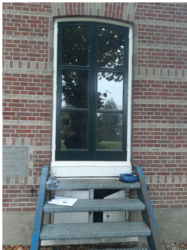
Afb. Voormalig schuifvenster ter plaats van de opkamer met daaronder een kelderraam met luiken uit een secundaire bouwphase.
