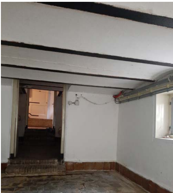
Afb. Gemetselde troggewelfjes met ijzeren liggers (1887) in de kelder.
