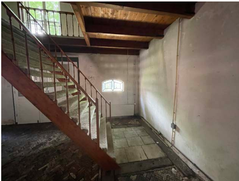
Afb. Voormalige wagenschuur. De trap en trapsparring dateren uit een secundaire bouwphase (XXd).
