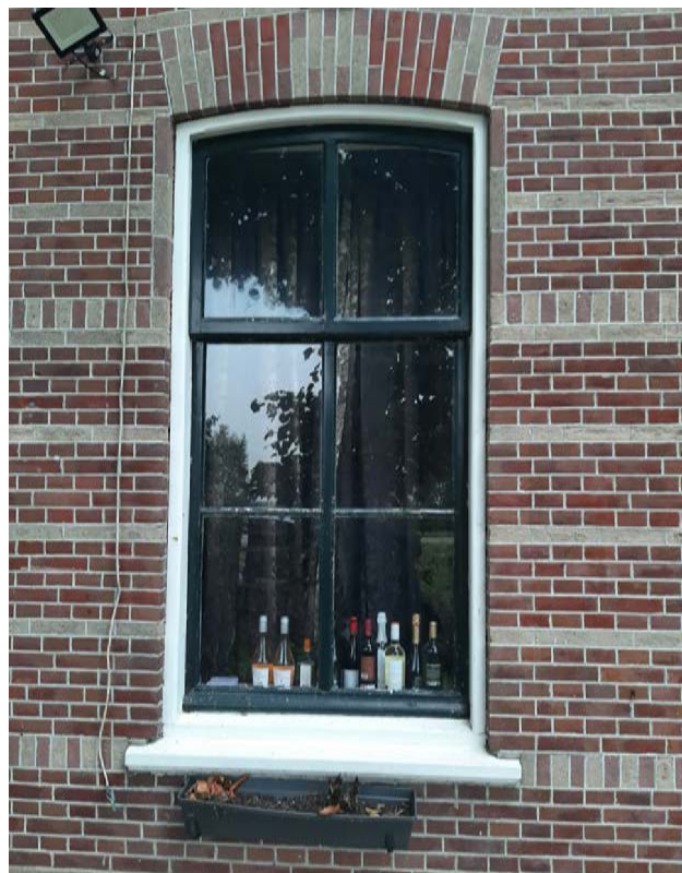
Afb. Schuifvenster uit de bouwtijd ter plaats van de voormalige woonkeuken. Hier is de oorspronkelijke geprofileerde houten raamdorpel nog aanwezig.
