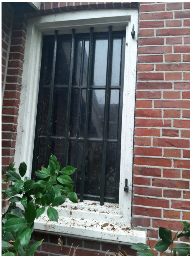
Afb. Venster uit de bouwtijd ter plaatse van de werkkeuken in het zomerhuis. Aan de binnenzijde van het kozijn bevindt zich een zesruits draairaam uit de bouwtijd. Goed zichtbaar zijn nog de luikspinning en luikgehengen aan de buitenzijde.
