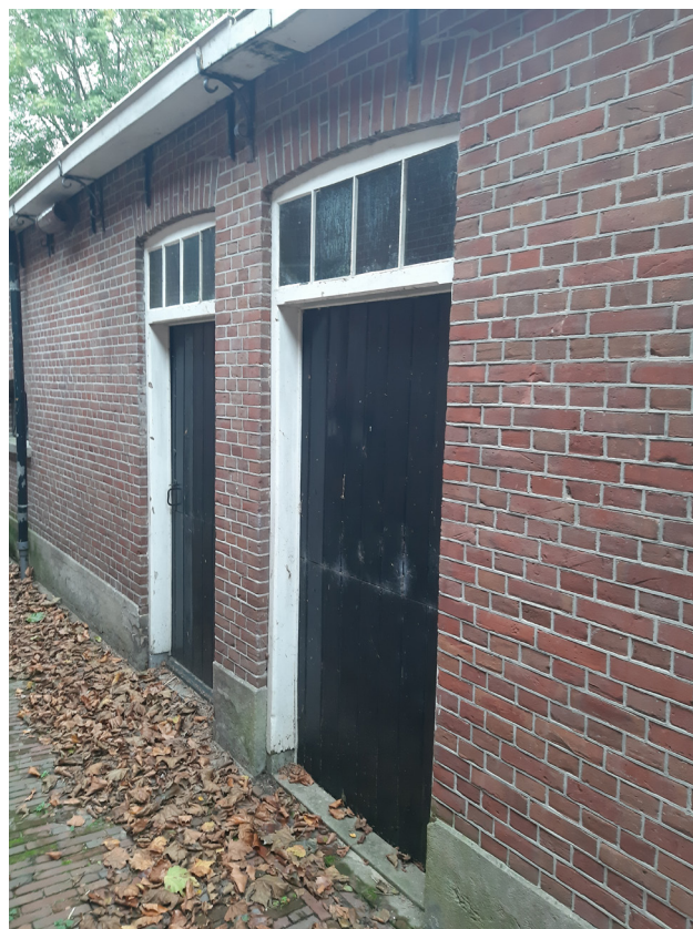
Afb. Boven-en onderdeuren van het stalgedeelte. De deurkozijnen zijn qua uitvoering en detaillering gelijk aan het kozijn van de zij- ingang naar de werkkeuken van de boerderij
