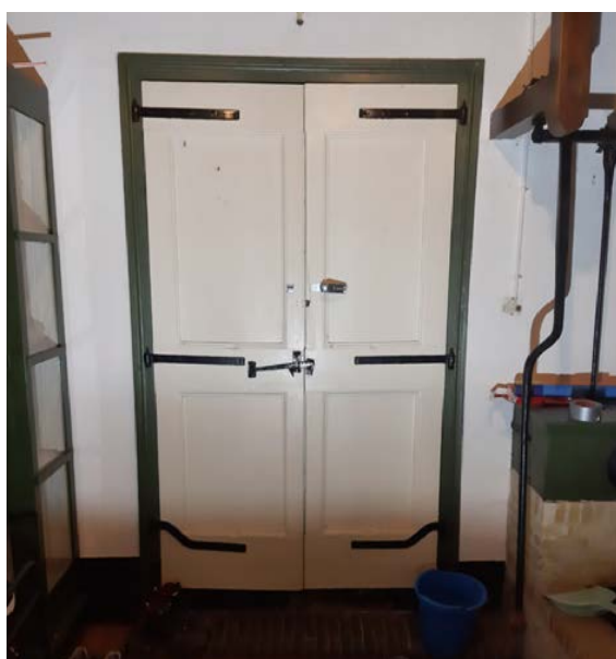
Afb. Dubbele opgeklampte deuren op gehangen ter plaaste van de voergang in het stalgedeelte.
