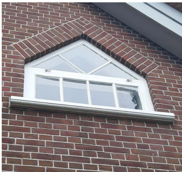
Afb. Rechter keperboogvenster in de achtergevel. Duidelijk zichtbaar zijn de restanten van ingeslagen paumelle scharnieren. Vermoedelijk waren de onderramen oorspronkelijk kleppend, zodat de achterliggende hooizolder geventileerd kon worden.
