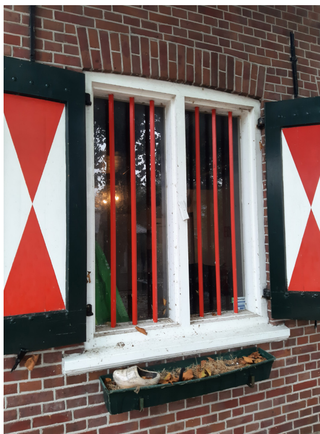
Afb. Tweelichtvenster uit de bouwtijd ter plaatse van het stalgedeelte.
