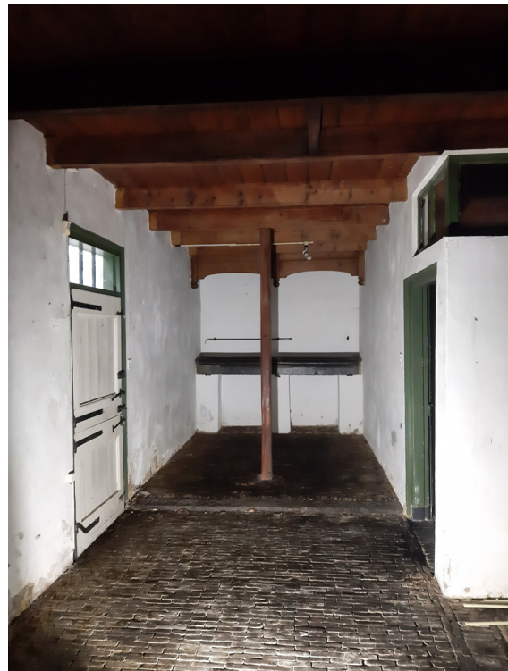
Afb. Draagconstructie uit de bouwtijd; de verdiepingsvloer ter plaatse van de werkkeuken. Het schuifvenster met schuifluiken bevindt zich in de voorgevel van het zomerhuis
