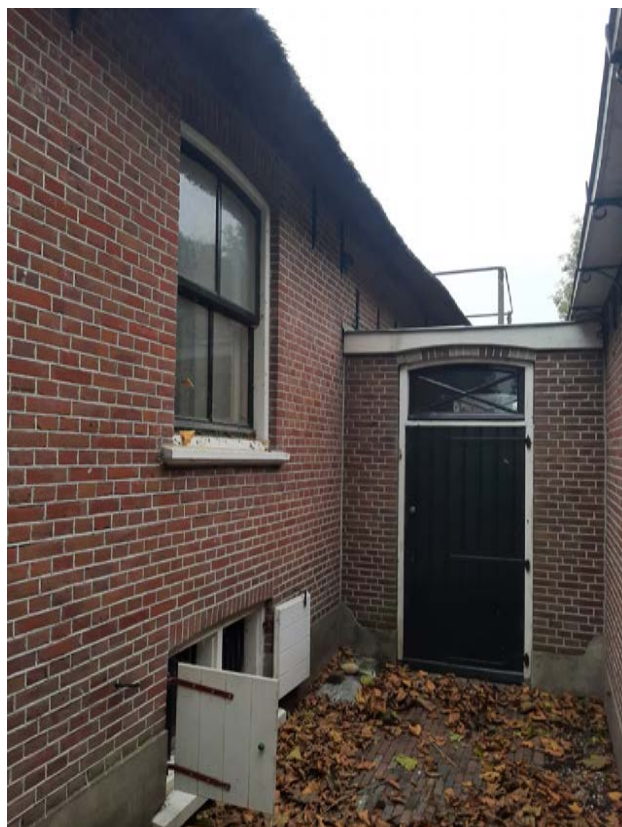
Afb. Rechter lansgevel van de boerderij ter plaats van het voorhuis (voorm. slaapkamer achter de opkamer). Duidelijk zichtbaar is de loopdeur in het tussenlid tussen boerderij en het zomerhuis.
