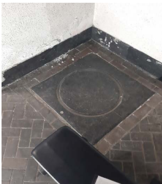
Afb. Natuursteen grondplaat voor karnton in werkkeuken
