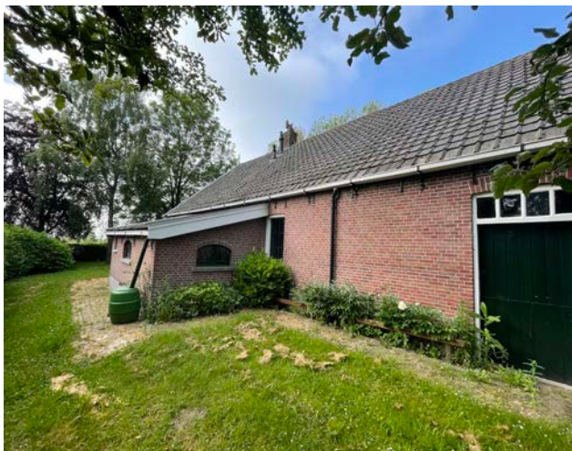
Afb. Rechtergevel van het zomerhuis. Ter plaatse van het voormalige stalgedeelte. Links de boven-en onderdeur uit de bouwtijd, rechts daarvan een in een secundaire bouwphase bijgeplaatste deur met zijraam.
