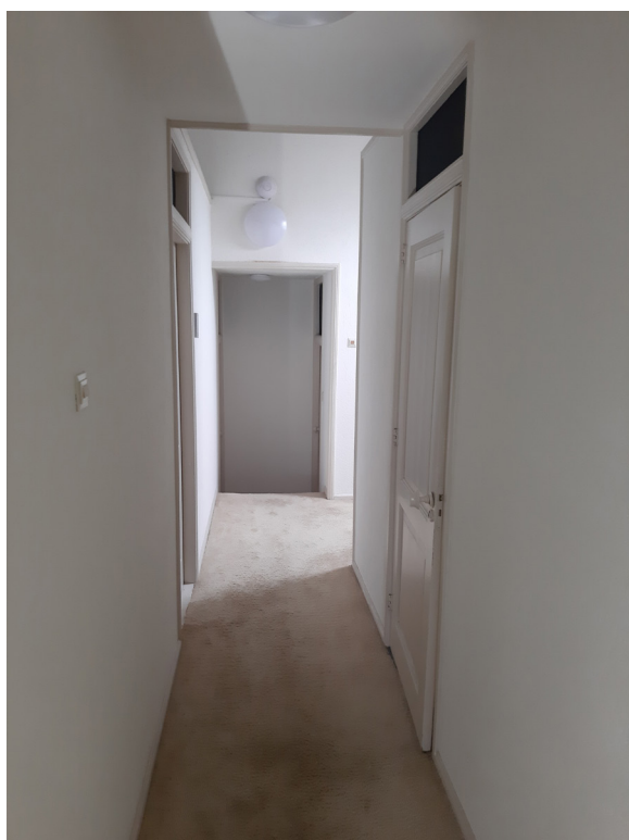
Afb. Zolderverdieping boven het voorhuis kijkend richting het achterhuis. De doorgang midden op de foto bevindt zich in de brandmuur tussen het voor- en achterhuis.
