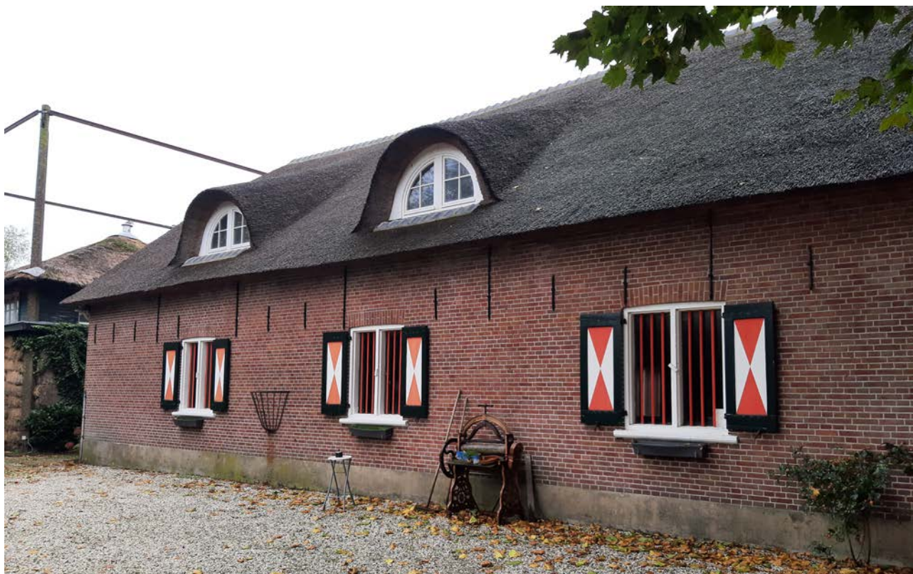
Afb. Linker lansgevel van de boerderij ter plaats van het achterhuis (stalgedeelte) met tweelichtvensters voorzien van geprofileerde raamdorpels, dievenijzers en houten luiken (vernieuwd XXB).
