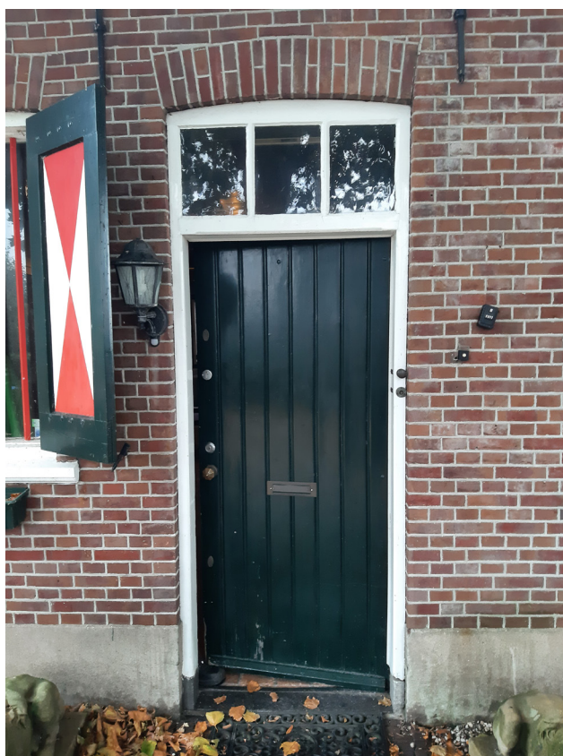
Afb. Zij-ingang ter plaatse van de werkkeuken. Het deurkozijn met drieruits bovenlicht is gelijk in uitvoering en detaillering als bij de loopdeuren in het stalgedeelte van het naastgelegen zomerhuis.
