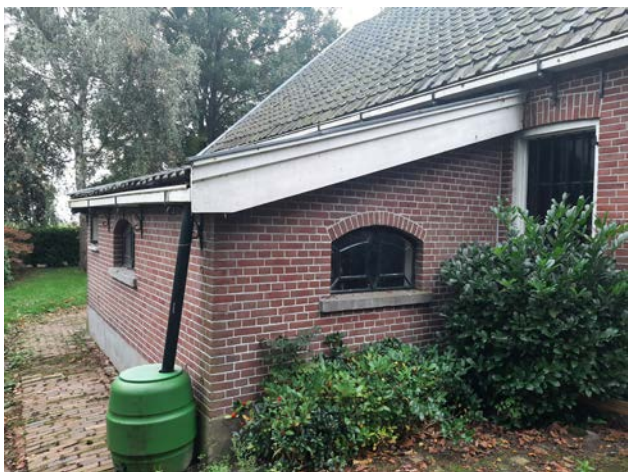
Afb. Rechter- en achtergevel van het boenhok.
