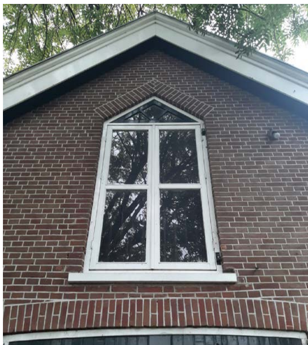
Afb. Keperboogvenster in de achtergevel van het zomerhuis. Vermoedelijk was dit de toegang tot de hooi- of bergzolder en was de opening oorspronkelijk afgesloten met een luik.
