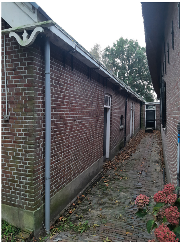
Afb. Linkergevel van het zomerhuis. Ter plaatse van het voormalige stalgedeelte zijn boven-en onderdeuren aanwezig. Deze zorgde voor extra ventilatie en daglicht. Tussen de twee voorste deuren een gietijzeren staldeur
