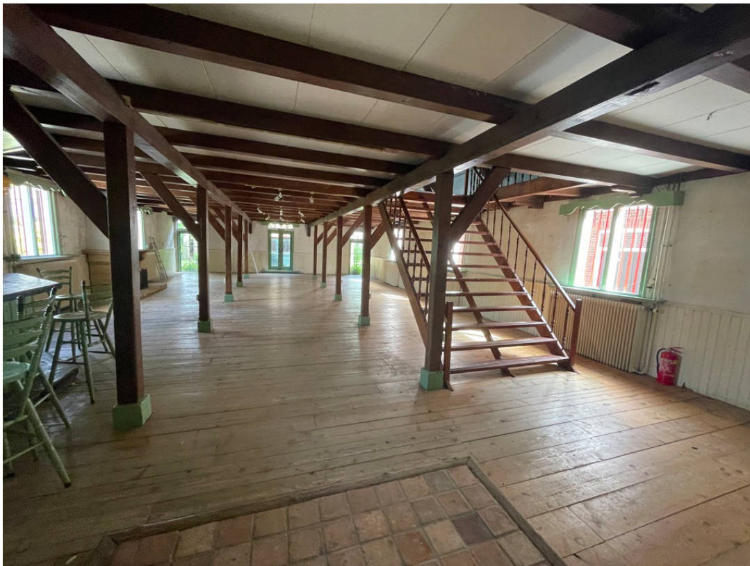
Afb. Voormalig stalgedeelte in achterhuis. De oorspronkelijke houtconstructie is nog aanwezig. De houten trap, plankenvloer en 'schoonloop' met estriken zijn in een secundaire bouwphase (XXd) ingebracht. De zoldering is niet zichtbaar door een recente gipsbeplating. Het is niet ondenkbaar dat deze is vernieuwd (na de brand in 2018 of nog eerder bij de verbouwing tot woon-/ antiekboerderij).
