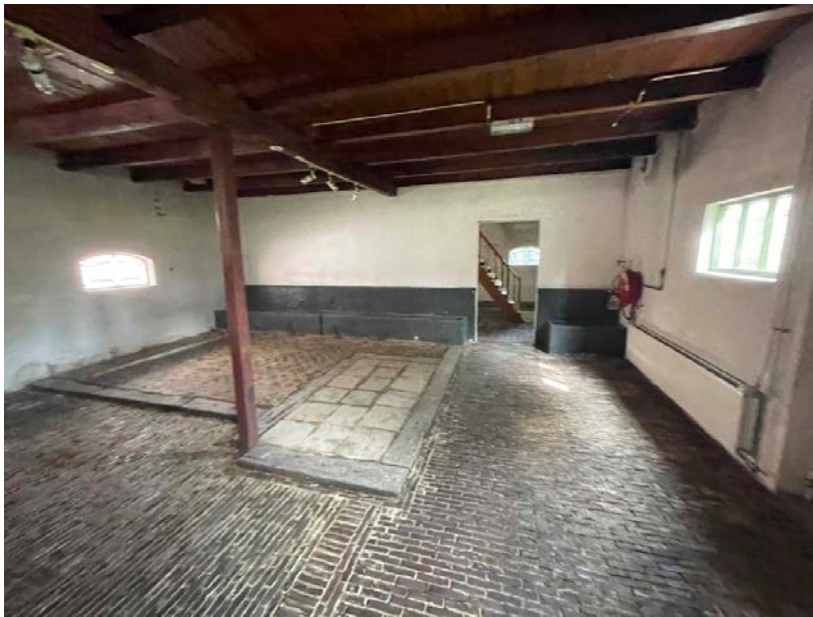
Afb. Stalgedeelte in het zomerhuis. Duidelijk zichtbaar is de wandsparring (XXd) die leidt naar de voormalige wagenschuur. Laag tegen deze wand bevinden zich prefab betonnen voedertroggen waar een 'hap' uit is genomen ten behoeve van de later aangebrachte wandsparring.
