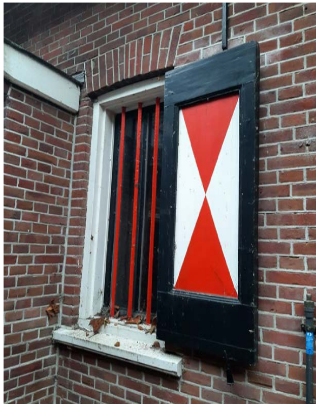
Afb. Enkelvoudig venster ter plaatse van de werkkeuken in de boerderij. Deze is aan de binnenzijde voorzien van een raam met middenroede uit de bouwtijd.
