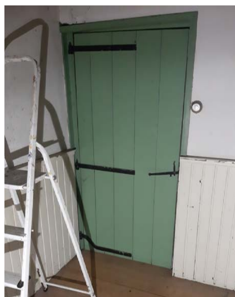
Afb. Opgeklampte deuren op gehangen ter plaaste van de kruigang in het stalgedeelte. Duidelijk zichtbaar is de verhoogde plankenvloer uit een secundaire bouwphase.
