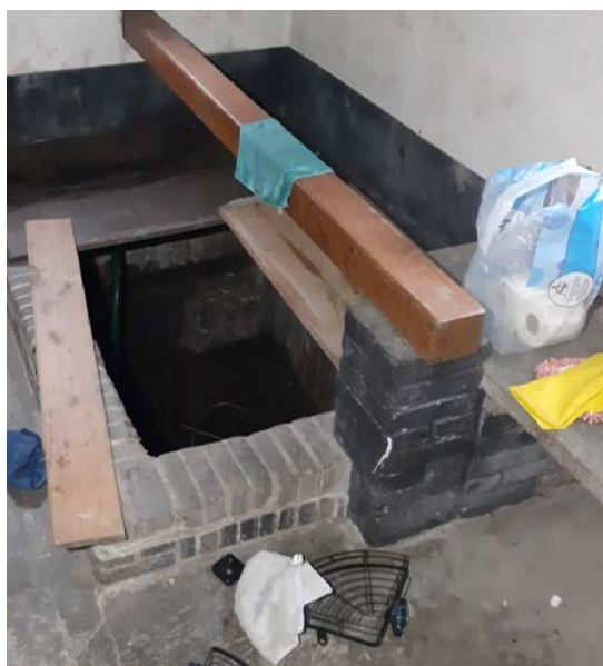
Afb. Waterput in het boenhok.
