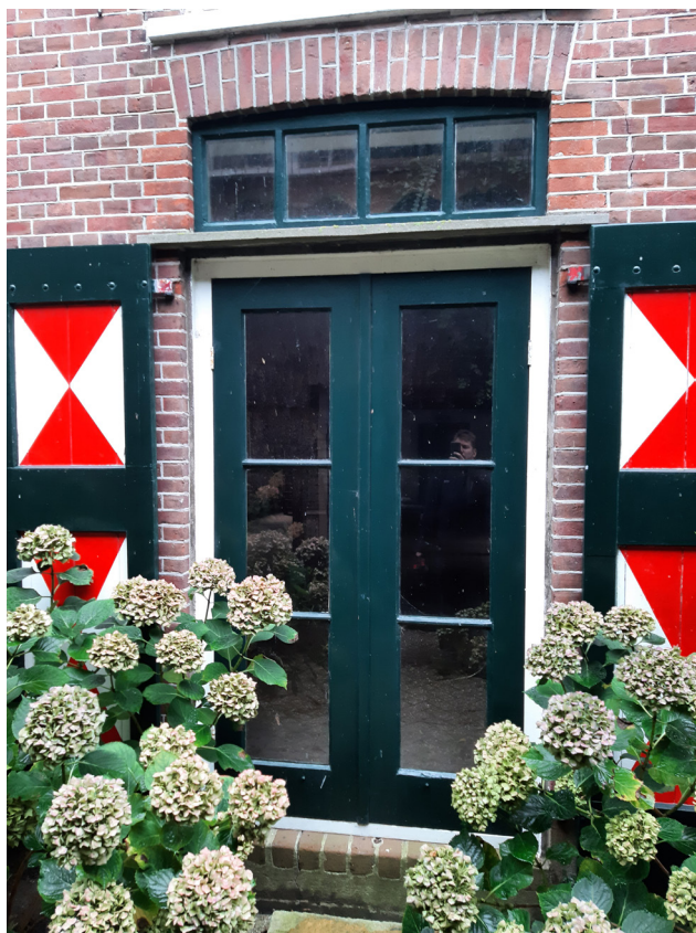
Afb. Gevelopening ter plaatse van de voergang. De stolpdeuren dateren uit een secundaire bouwphase. De onderdorpel lag oorspronkelijk een stuk lager (gelijk aan de voergang en de erfbestrating).
