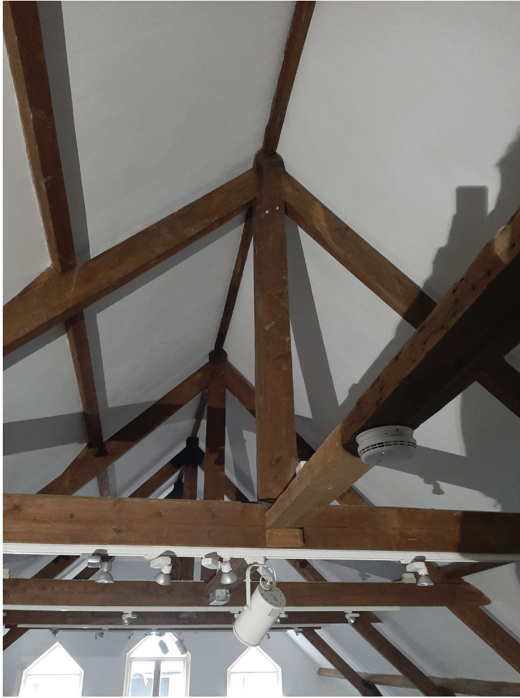
Afb. Bovenste deel van het nokstijlspant. De doorgaande schuin geplaatste nokgording is ingelaten in de makelaar en draagt samen met de andere gordingen bij aan de stabiliteit van de kap in de lengterichting.
