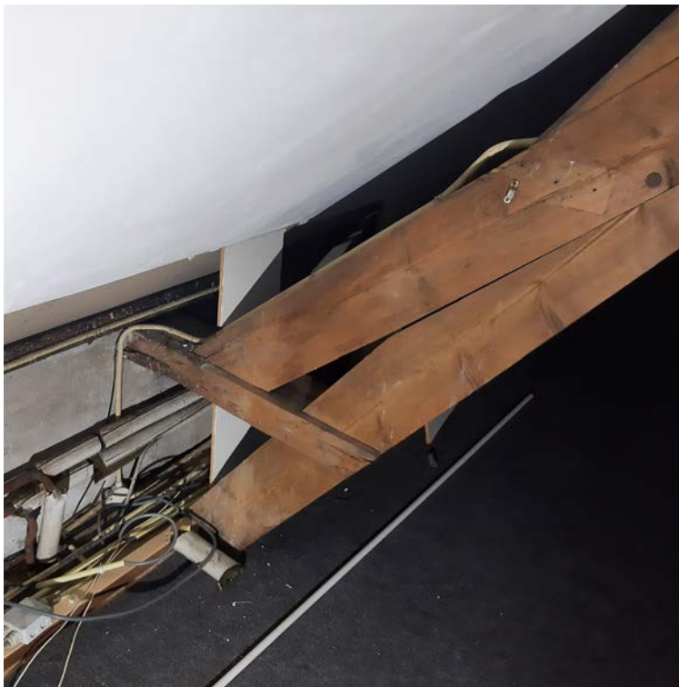
Afb. Onderste deel van het nokstijlspant waarvan de krupele stijl afdraagt op de onderliggende zolderbalk. Het spantbeen is via een blokeel verankerd aan de dragende zijmuur en draagt zo bij aan de stabiliteit van de kap in de dwarsrichting.
