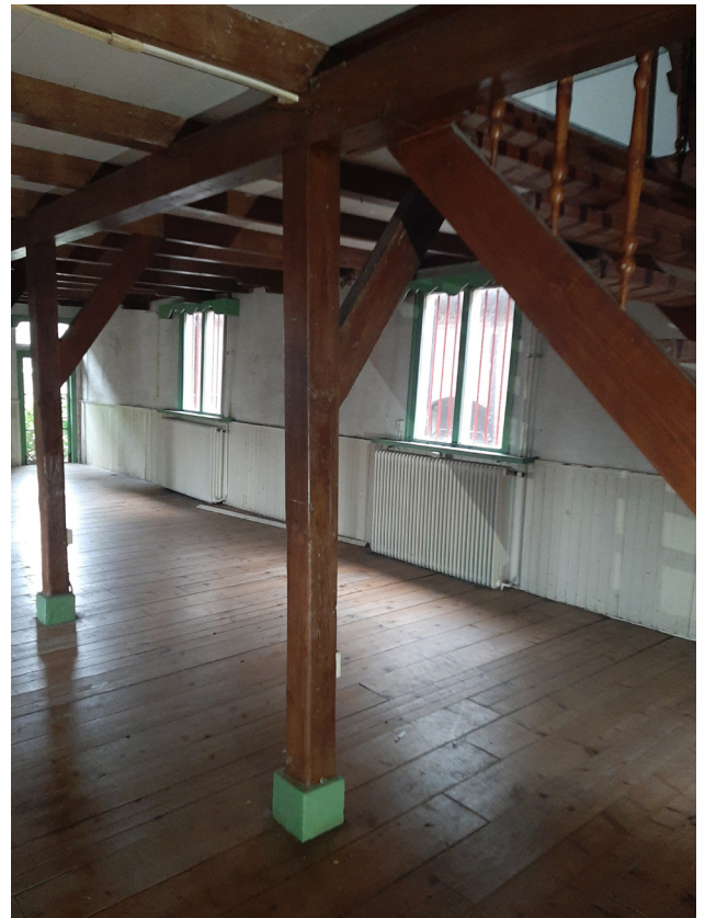
Afb. Houtconstructie in stalgedeelte.
