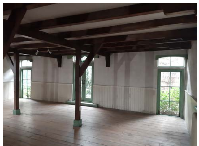
Afb. Draagconstructie uit de bouwtijd van de verdiepingsvloer in achterhuis. De zolderbalken zijn om en om voorzien van sleutelstukken. De trap(sparing) is in een secundaire bouwphase ingebracht.
