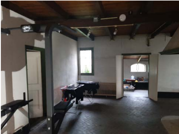
Afb. Draagconstructie uit de bouwtijd; de verdiepingsvloer ter plaatse van de werkkeuken in het zomerhuis. Achter de openslaande deuren is het boenhok zichtbaar.
