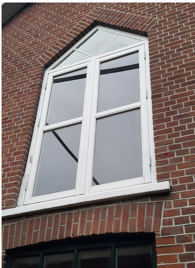
Afb. Gevelopening op de verdieping.
