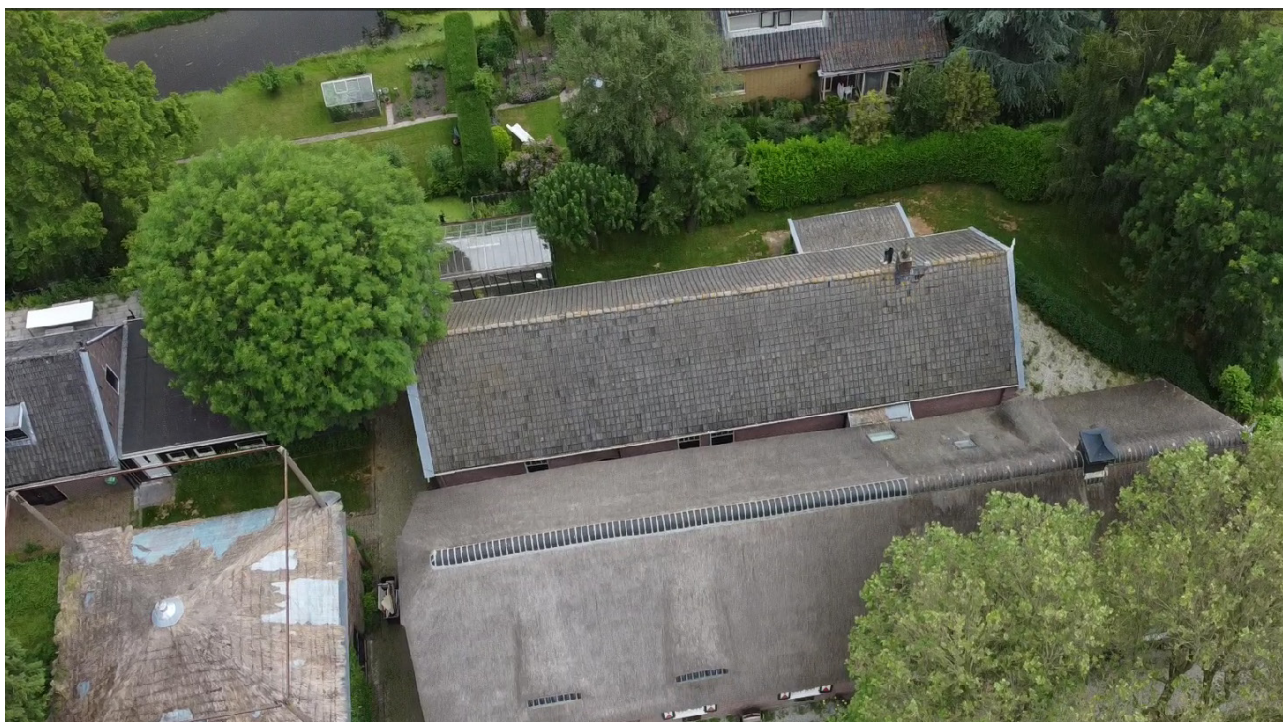
Afb. Luchtfoto met het dakaanzicht van de verschillende (bij)gebouwen op het erf. Duidelijk zichtbaar is de (na een brand in 2018) vernieuwde rietbedekking van het achterhuis van de boerderij. Daarbij is het schoorsteenkanaal (waar de brand in ontstond) niet meer teruggebouwd.
