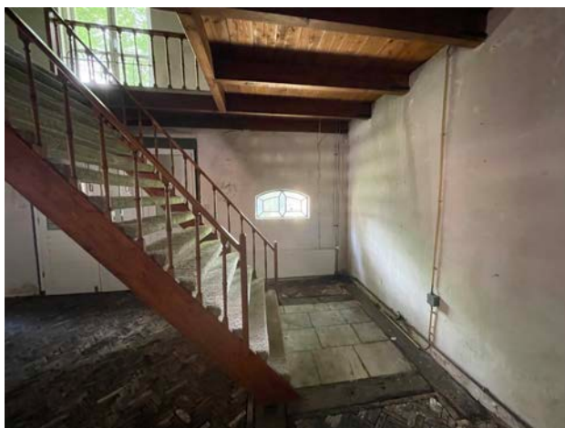
Afb. draagconstructie uit de bouwtijd; de verdiepingsvloer ter plaatse van de voormalige wagenschuur in het zomerhuis. De trap(sparing) dateert uit een secundaire bouwphase.
