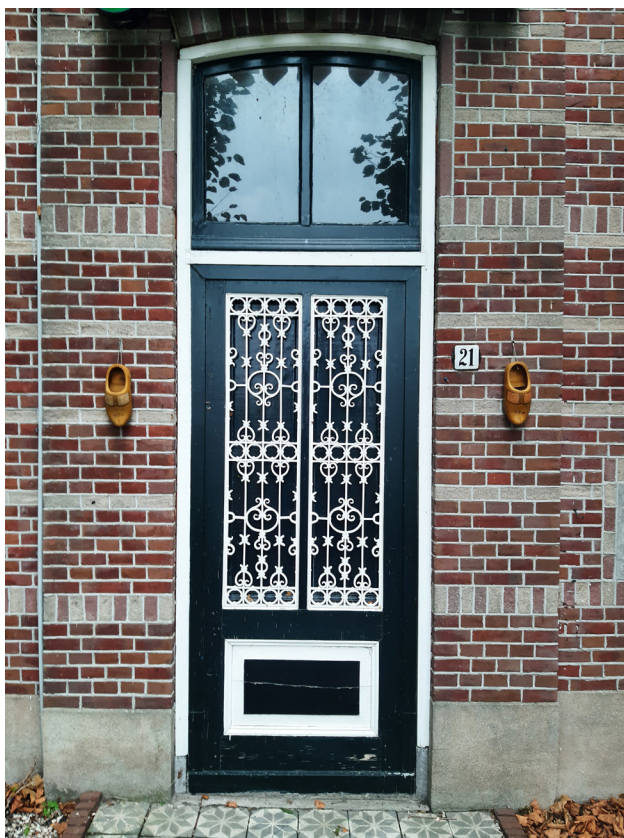
Afb. Voordeur boerderij. De bovenregel van het kozijn en de natuursteen neuten zijn voorzien van een biljoening. Het middenkalf en de kozijnstijlen zijn vernieuwd.
