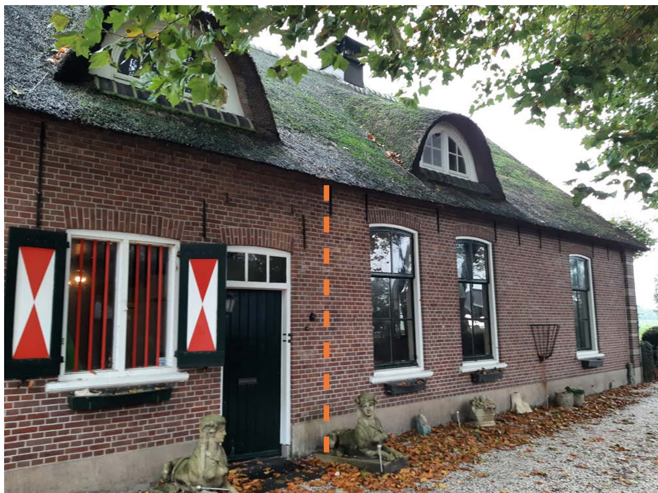
Afb. Linker langsgevel van de boerderij met rechts van de oranje stippelijn de drie zesruits schuifvensters ter plaats van het voorhuis. Links van de stippelijn het tweelichtvenster en de zijdeur ter plaatse van de werkkeuken in het achterhuis.
